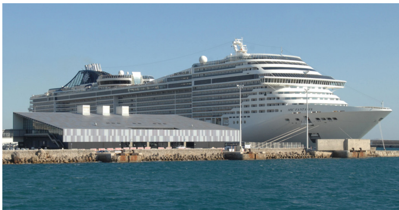
La Gare Maritime de la Major nel porto di Marseille-Fos.
