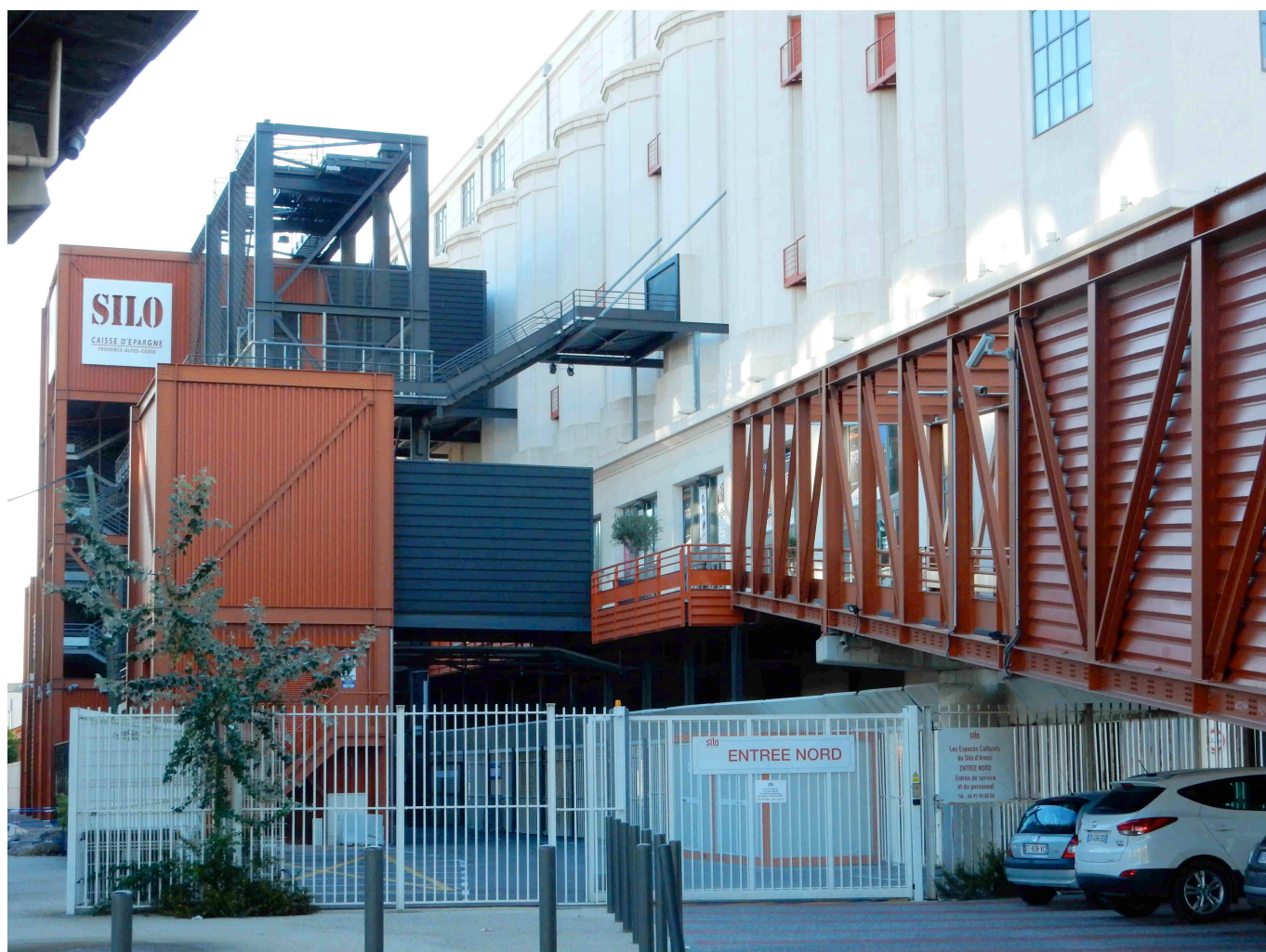
Le Grand Silo, entrée de la salle de spectacles.
