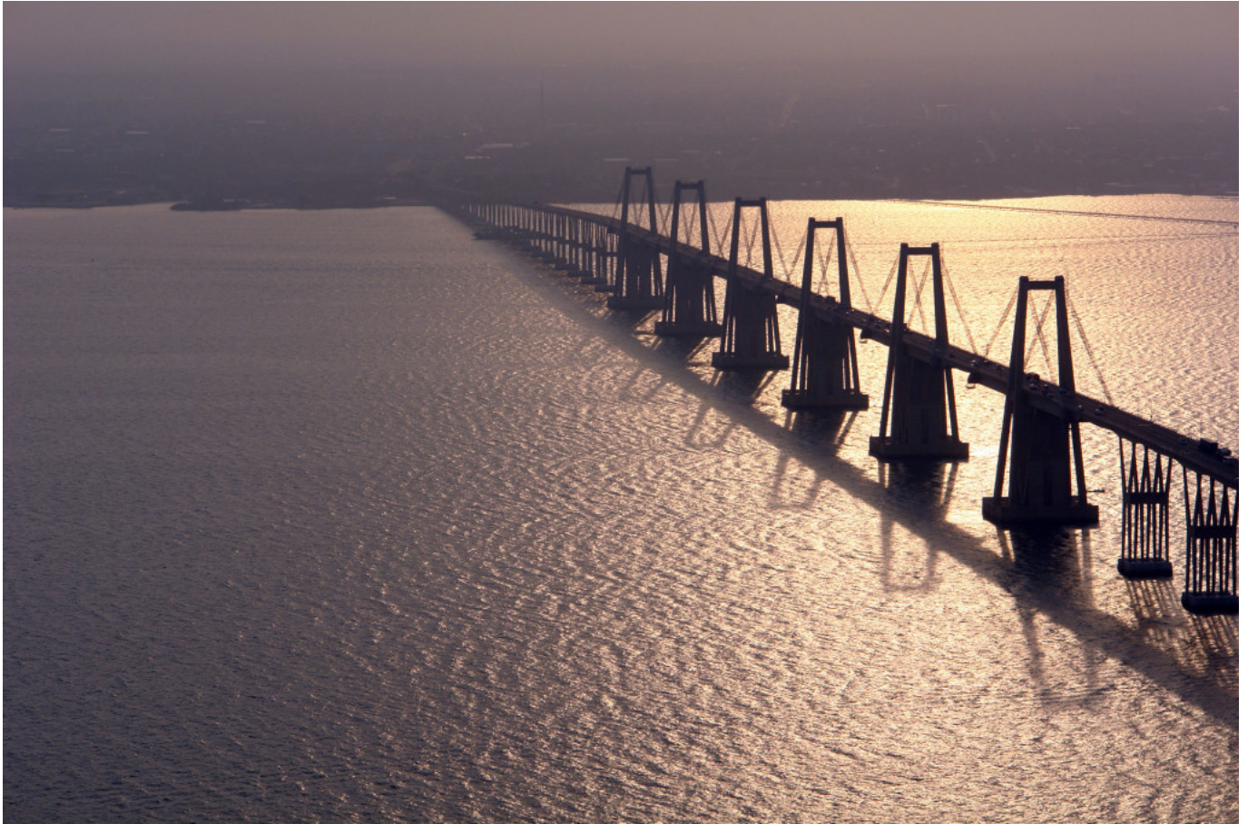
Puente sobre el lago de Maracaibo. (© Mario Alvarado)
