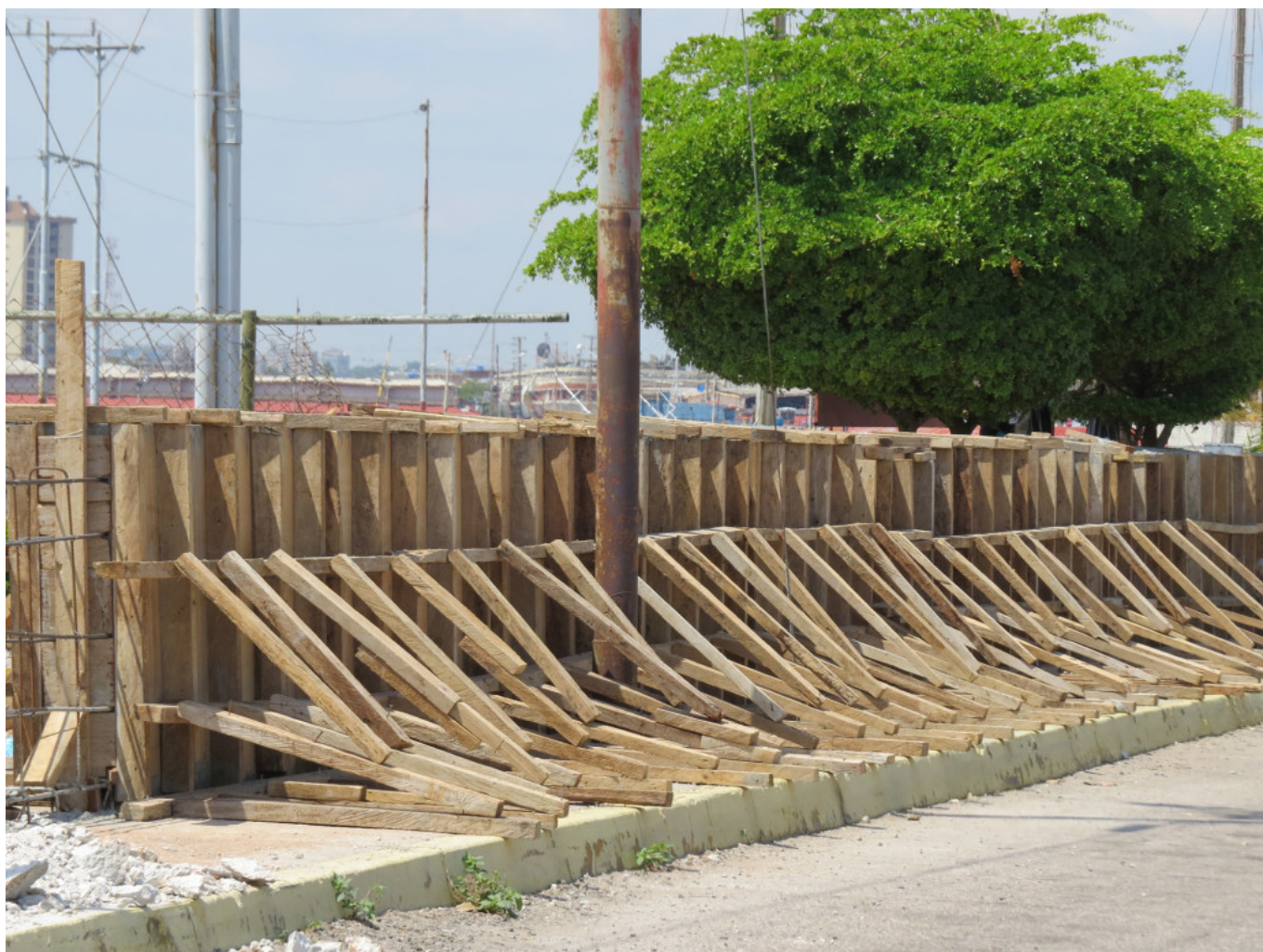
Muro en construcción en el Malecón (2013). (© Pedro Romero)
