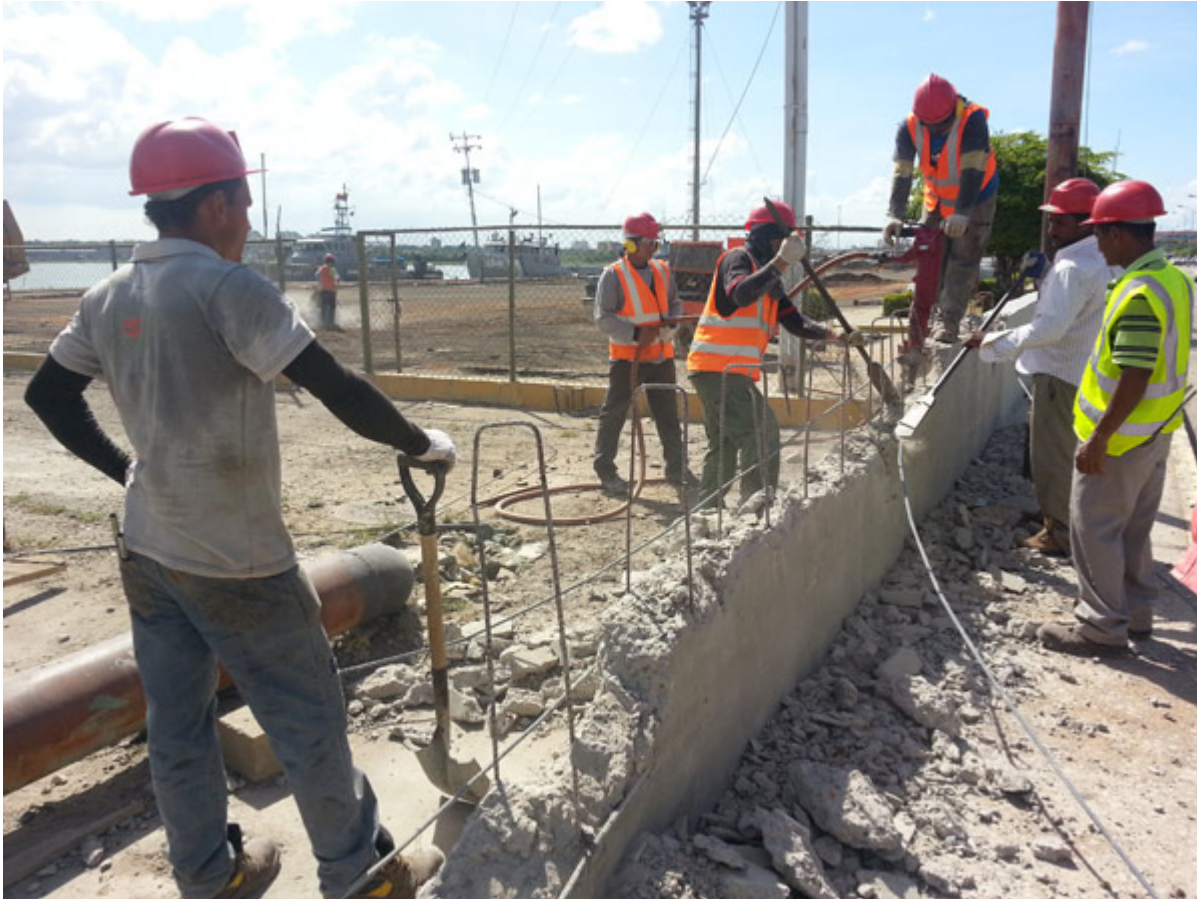
Demolición del muro del Malecón (2013). (© Diario Panorama)
