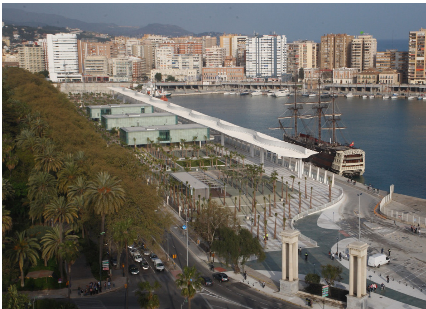
Il porto urbano e uno scorcio dei giardini realizzati lungo la passeggiata Palmeral de las Sorpresas.
