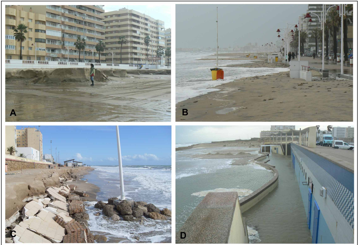
Ejemplos de impactos de temporales en las playas de Cádiz. A) Erosión en La Victoria en enero de 2010. B) Arrasamiento en La Victoria en enero de 2010. C) Erosión en La Victoria en mayo de 2016. D) Inundación en Cortadura en marzo de 2010.
