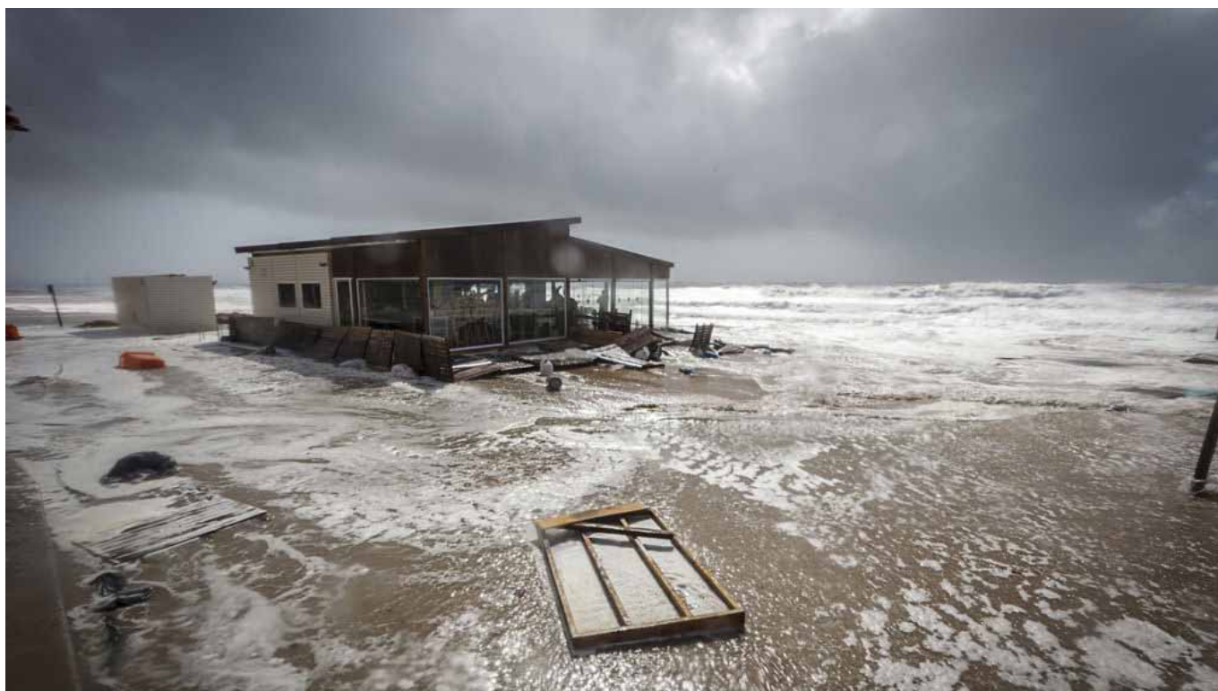
Inundación y daños en un establecimiento de restauración de la playa de La Victoria durante la tormenta Emma en marzo de 2018. (Fotografía: Diario de Cádiz)
