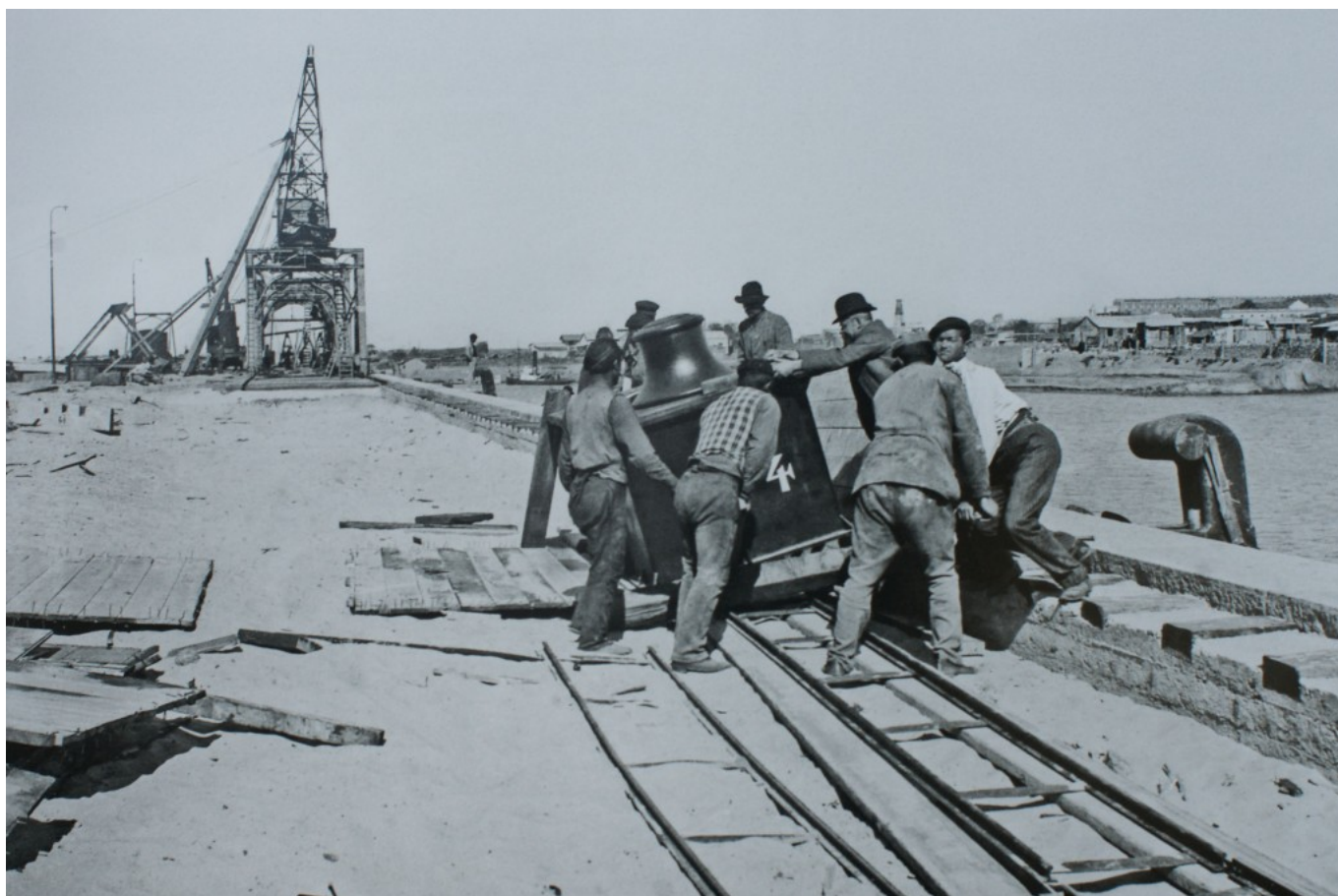
Construcción del dique I. Aplicación de amarres en el muelle oeste, ca 1910. (© José Beleno)
