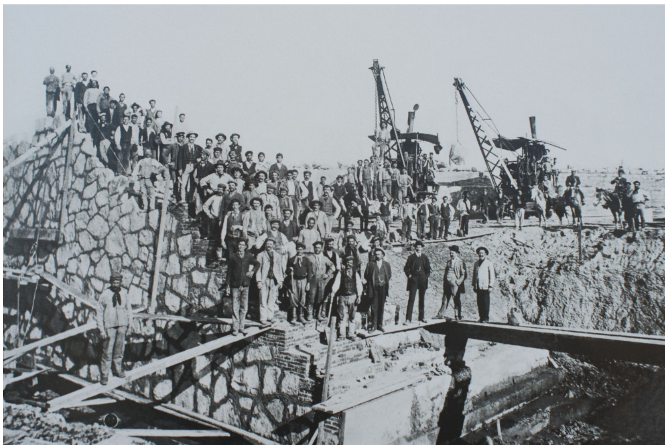
Obreros e ingenieros de la obra sobre un muelle del dique I, ca 1909. (© José Beleno)
