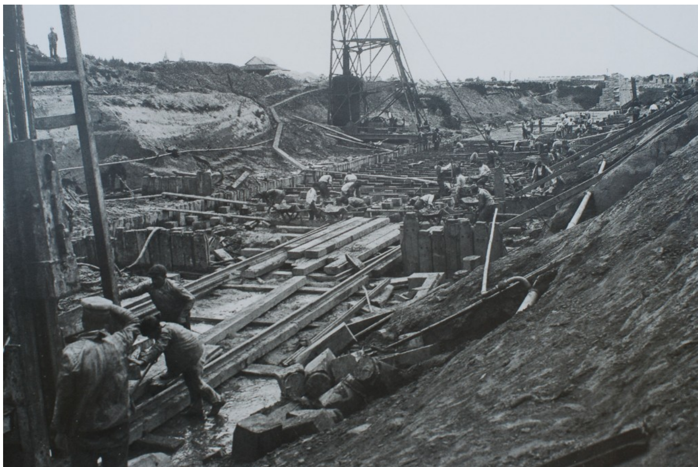
Construcción del dique I, ca 1908. (© José Beleno)
