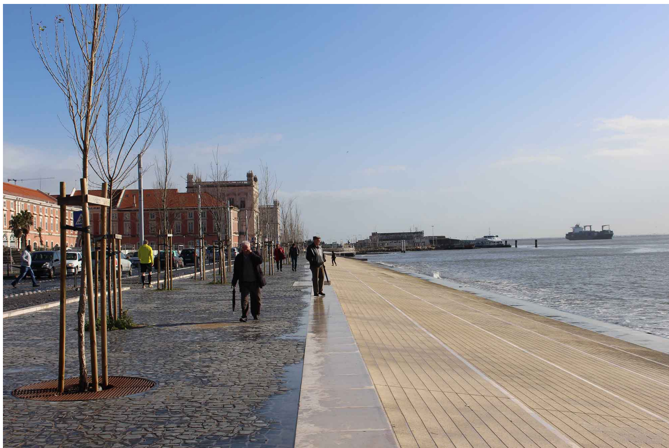
Vista parcial da intervenção da Ribeira das Naus. (Fonte: Própria)
