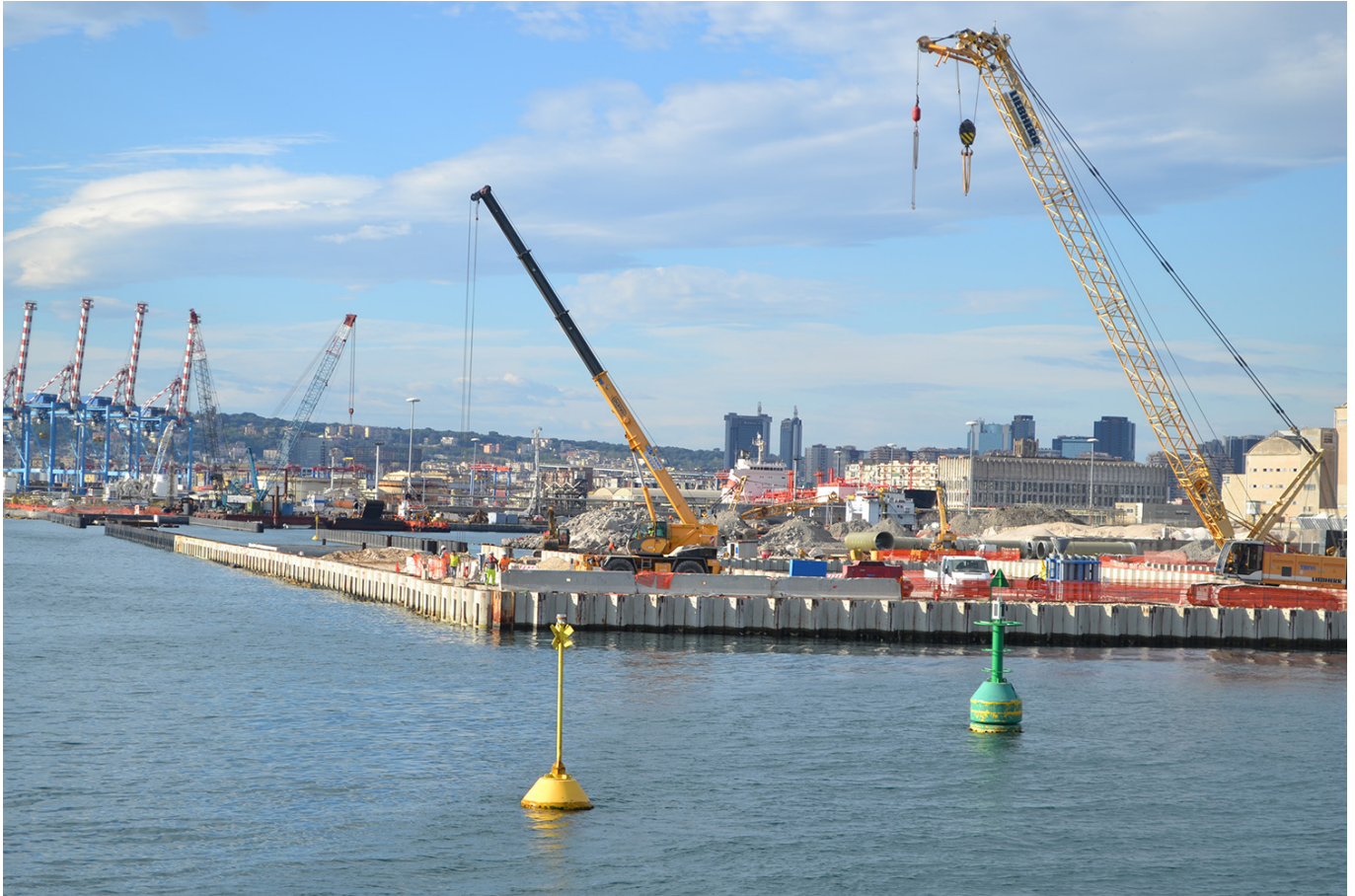
Lavori in corso per l'espansione della darsena di Levante.
