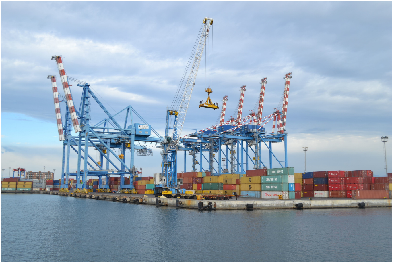
Area con le gru per la movimentazione e lo stoccaggio dei container.
