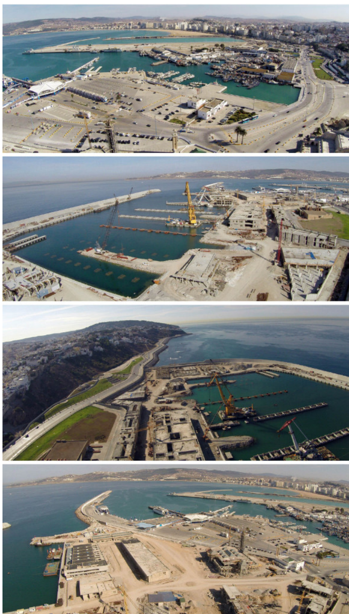
Avancement des travaux: Octobre 2015.
