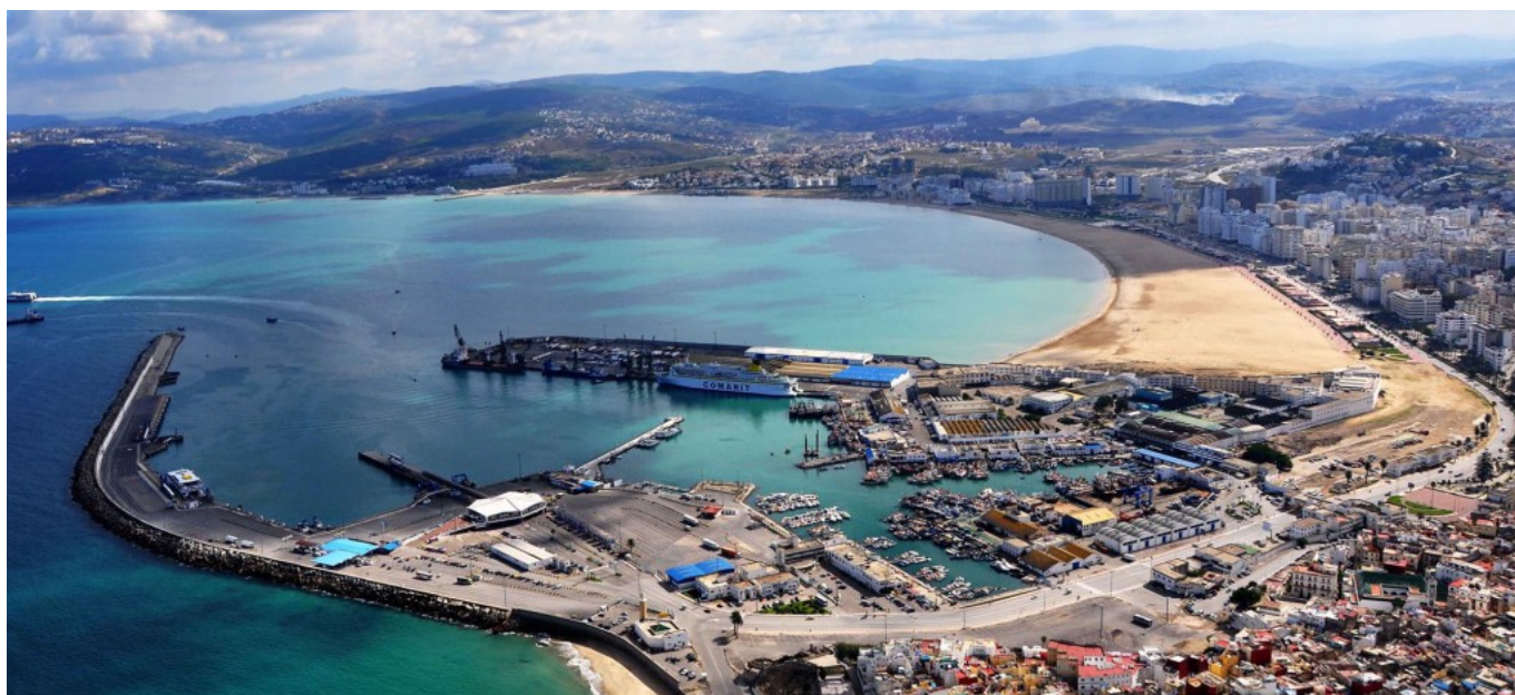
Avancement des travaux: Octobre 2011.
