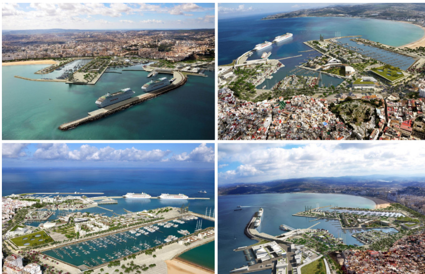
Vues générales de différents points (nord, sud, est et ouest) sur le site reconverti.
