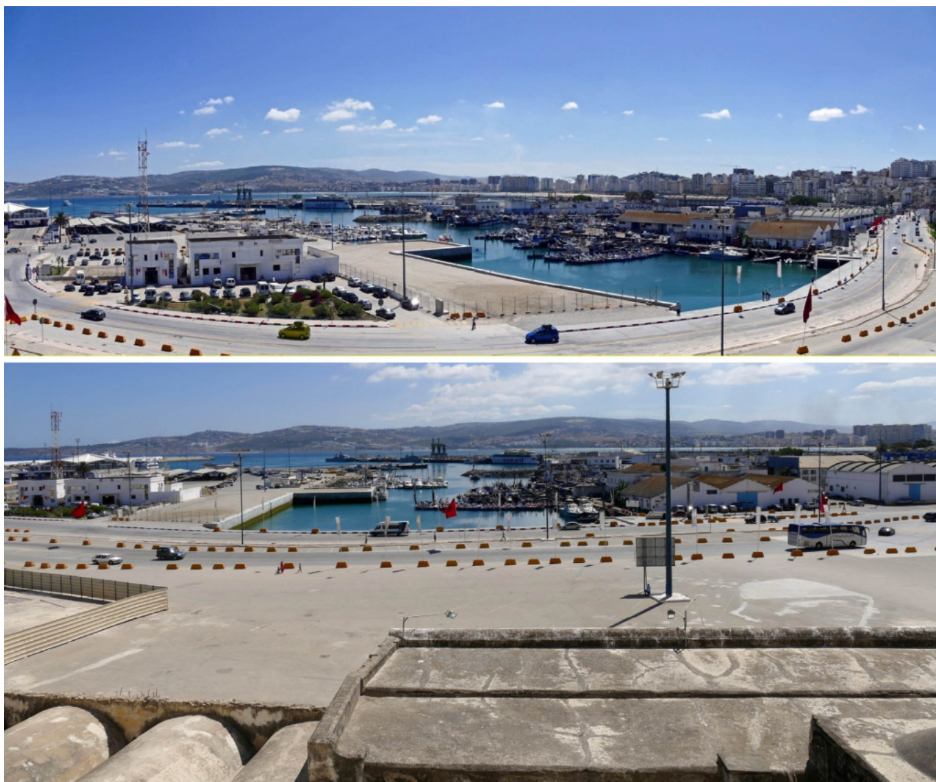
Avancement des travaux de reconversion du port de pêche actuel en marina.
