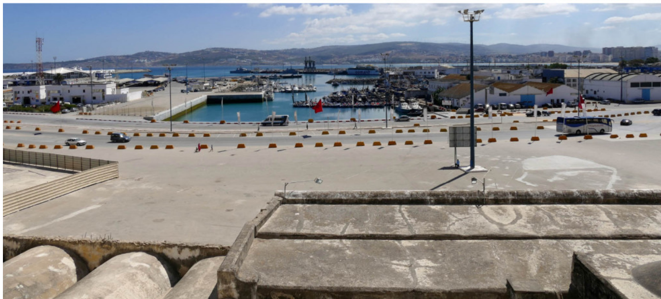
Avancement des travaux de reconversion du port de pêche actuel en marina.
