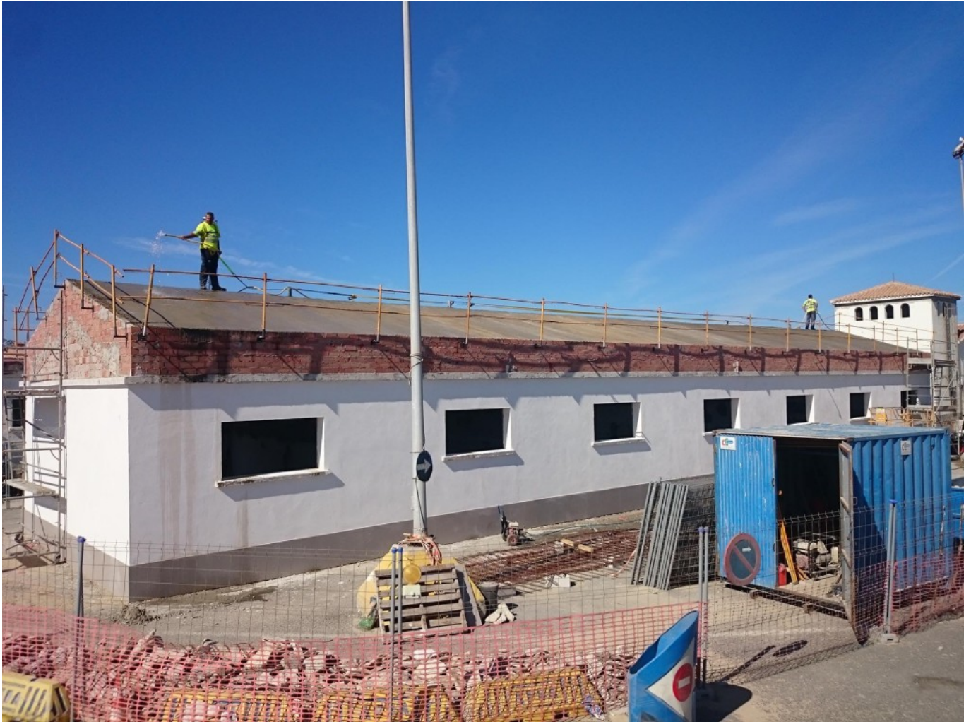
Locales durante la obra de rehabilitación.
