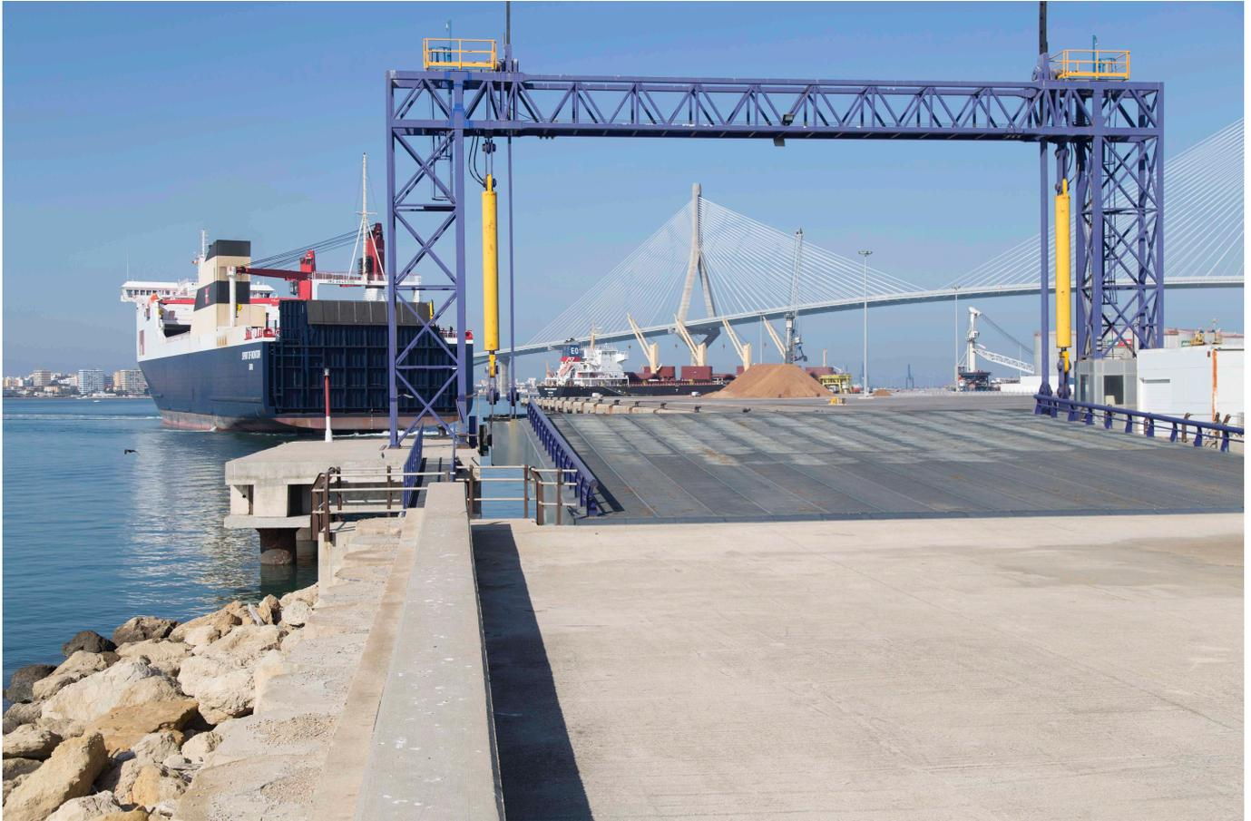
*Rampa roro ubicada el muelle de La Cabezuela-Puerto Real, utilizada por Airbus para embarcar las piezas que produce en la planta de Puerto Real. (© Autoridad Portuaria de la Bahía de Cádiz)*
