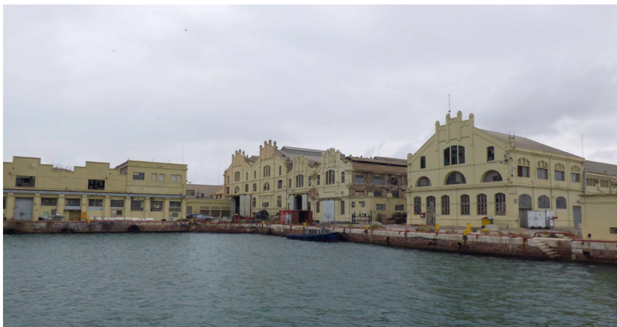
Panorámica de las principales naves de talleres, 2018. (© Manuel Carreres Rodríguez)
