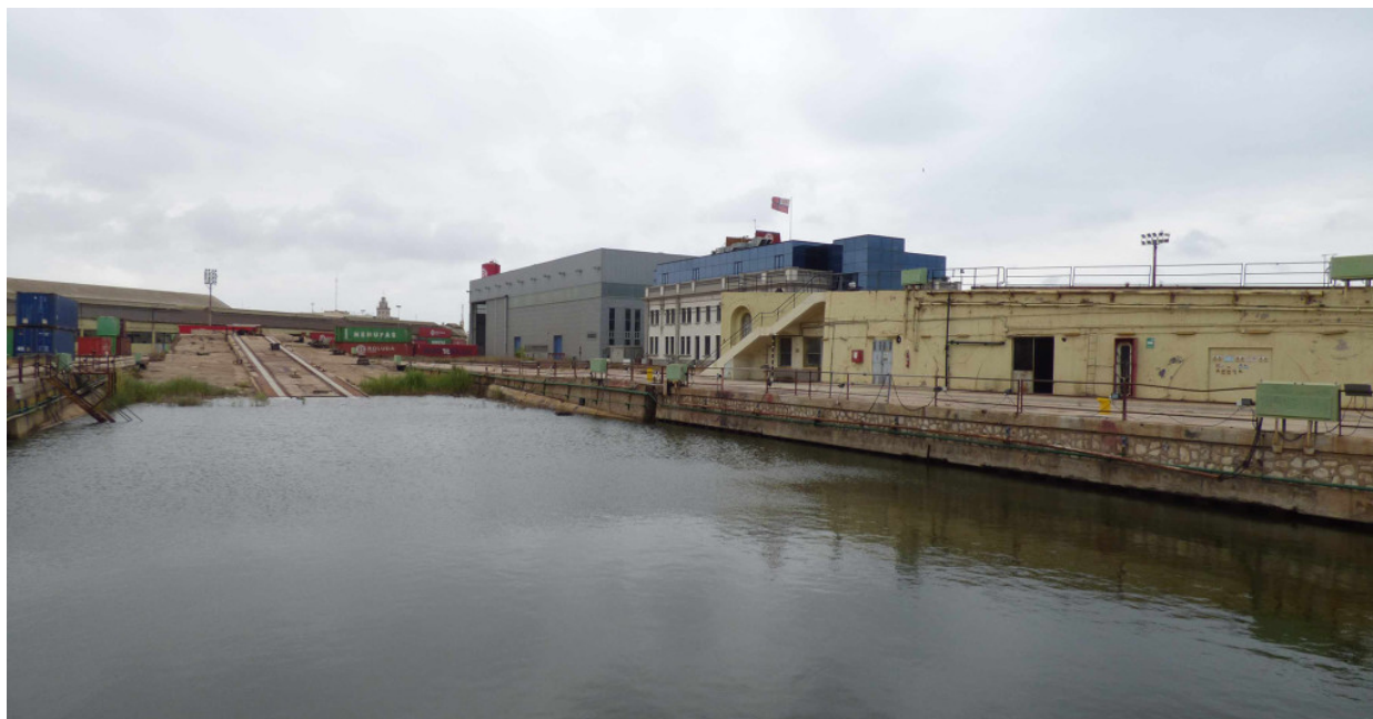
Detalles de las gradas conservadas. Tras ellas, a la derecha, el edificio de oficinas,
