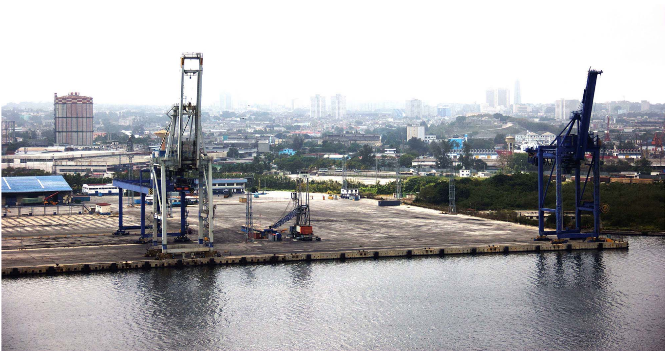
Terminal de contenedores de La Habana.
