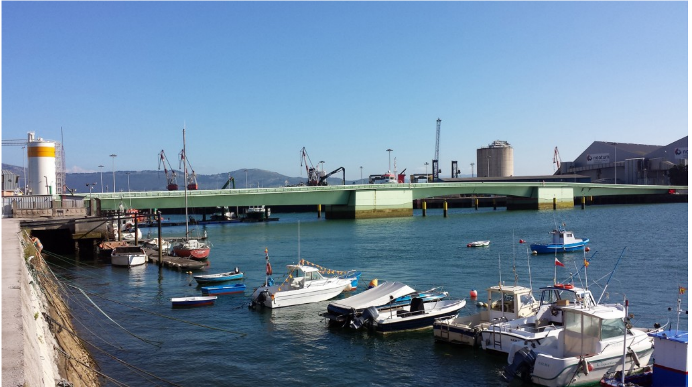
Puente de conexión entre los muelles de Maliaño y Raos. (Foto: Román R. Luna)
