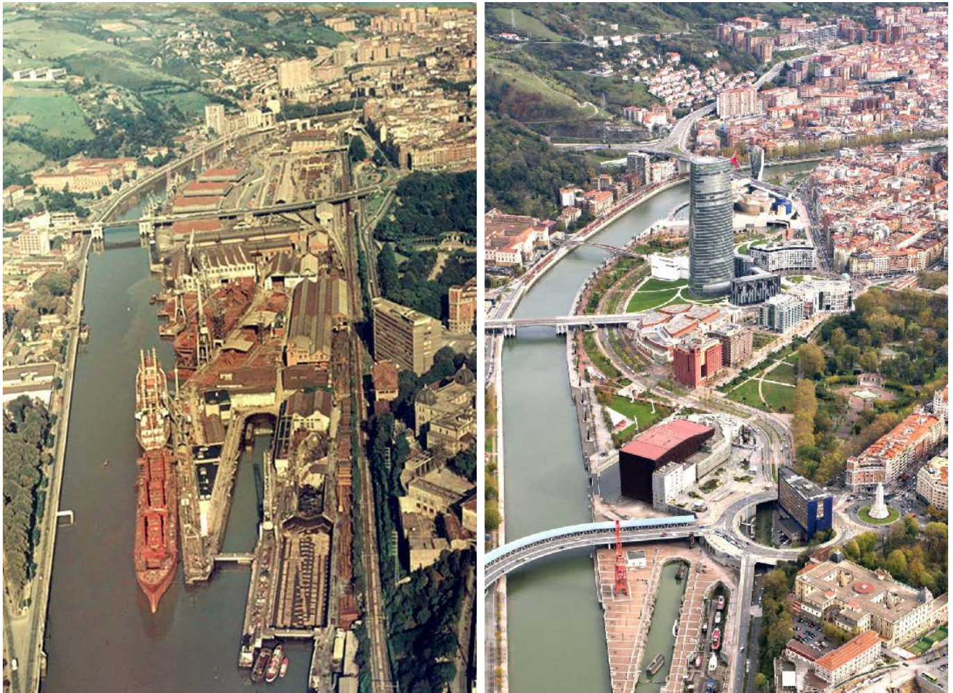
La transformación de Abandoibarra.
