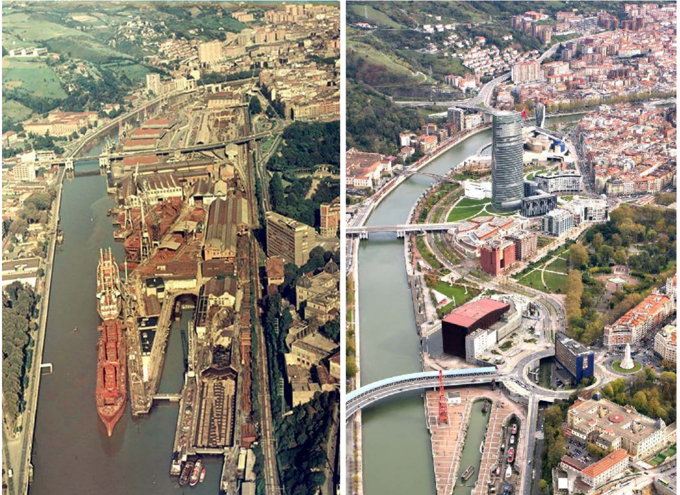
La transformación de Abandoibarra.
