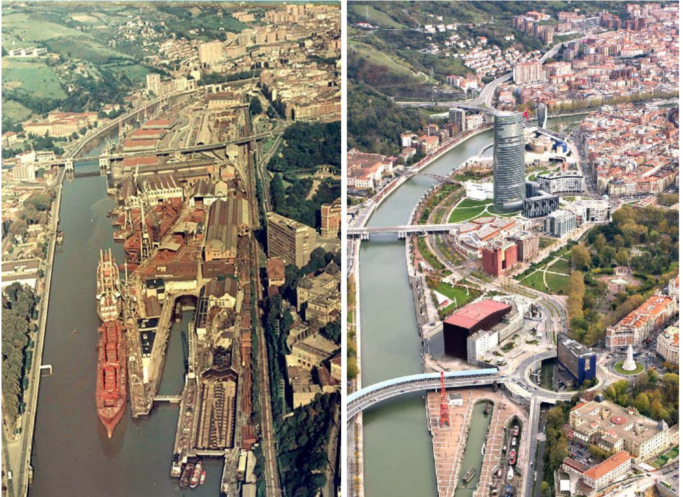
La transformación de Abandoibarra.
