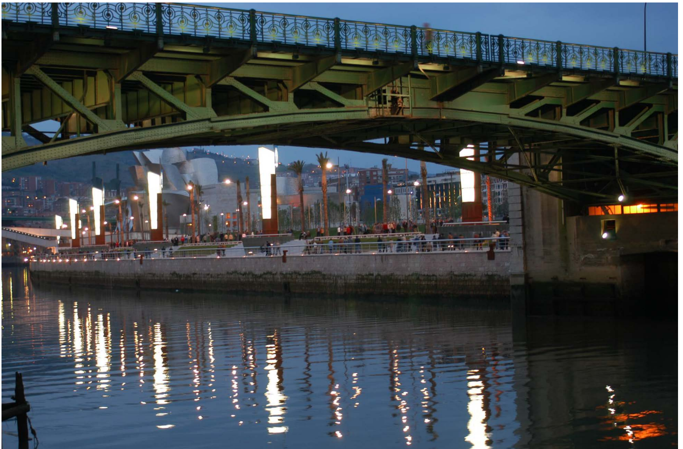
El puente de Deusto.
