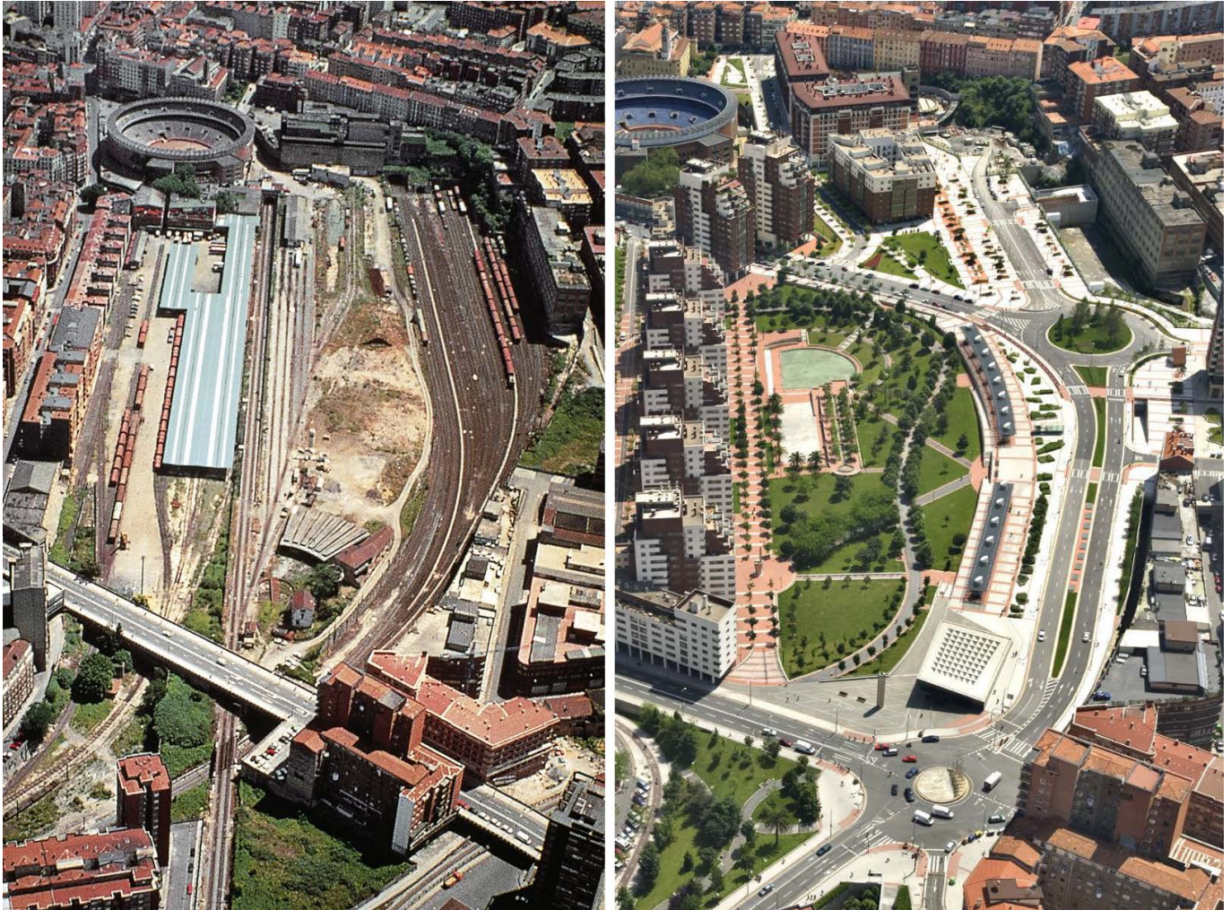
La transformación de la estación de mercancías de Amezola.
