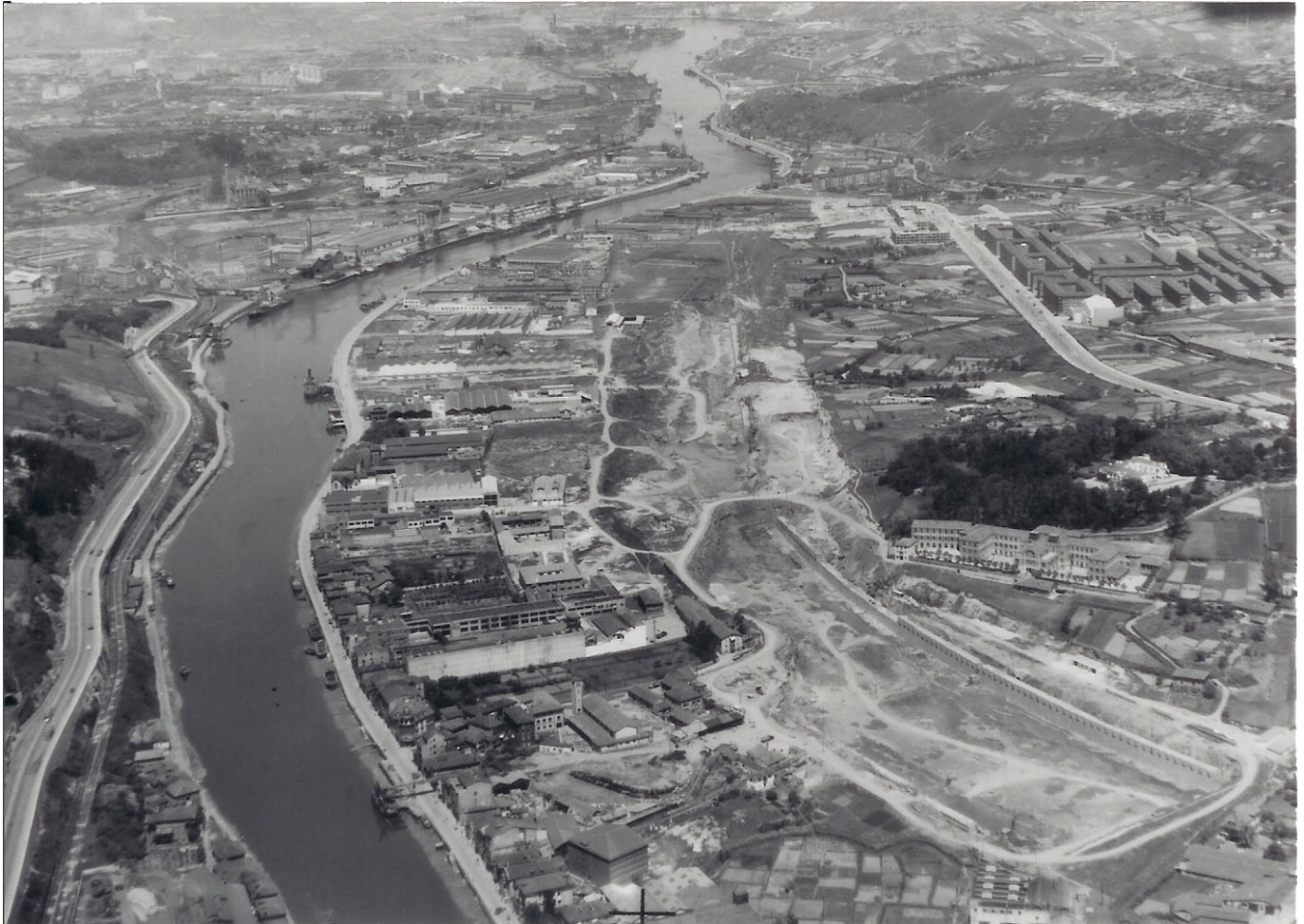
Zorrotzaurre. Construcción del Canal de Deusto, 1960.
