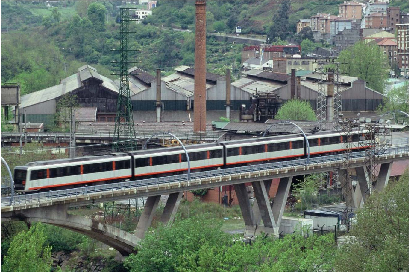
El metro atraviesa el río Ibaizabal, límite del término municipal de Bilbao.
