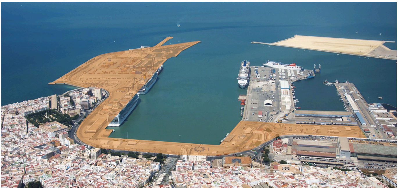
Ámbito de la Estrategia de Actuación Puerto-Ciudad en la dársena de Cádiz.
