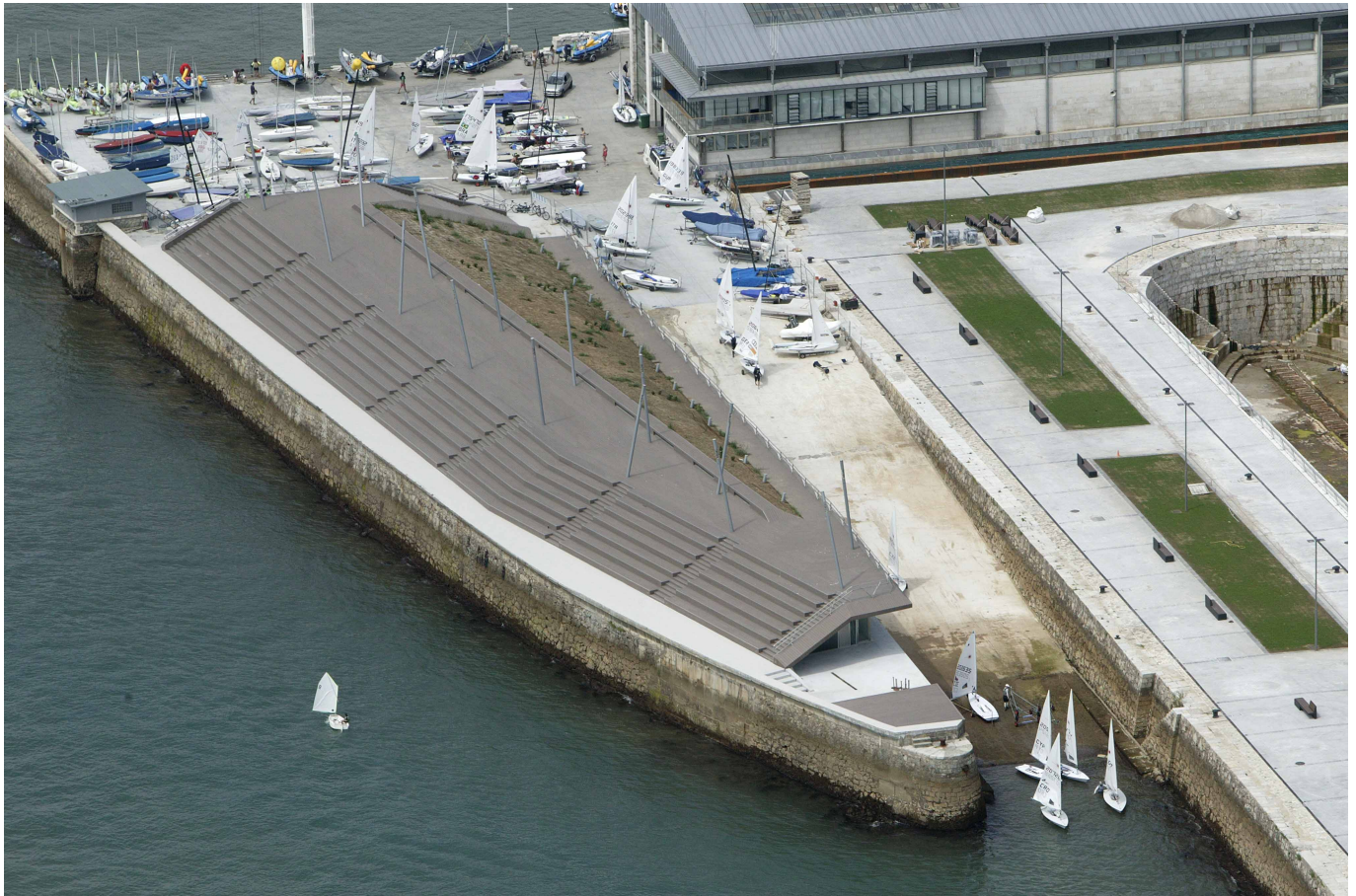
Centro de Alto Rendimiento de Vela. (Fuente: Archivo APS)
