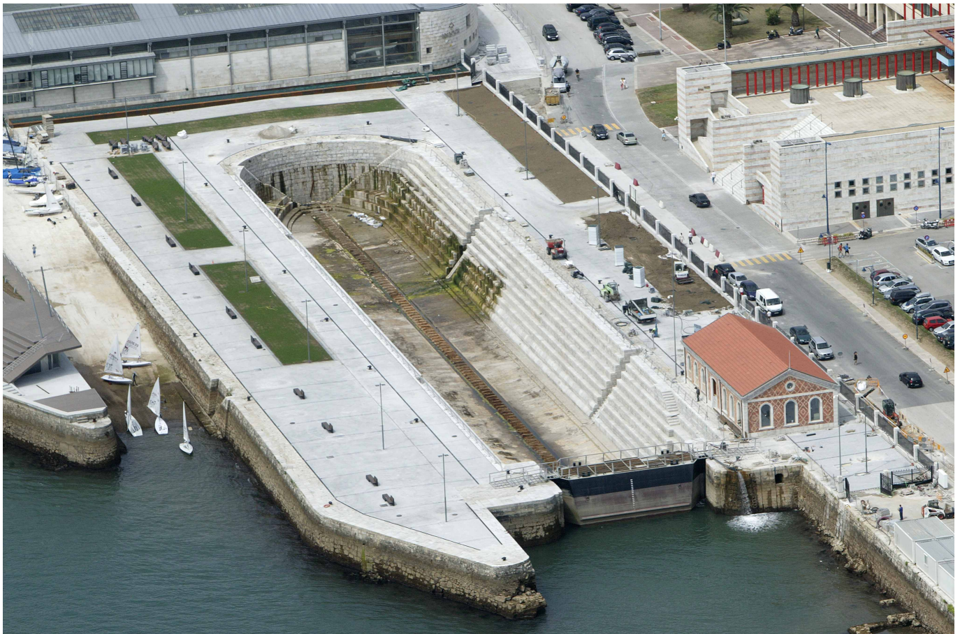
Dique de Gamazo. (Fuente: Archivo APS)
