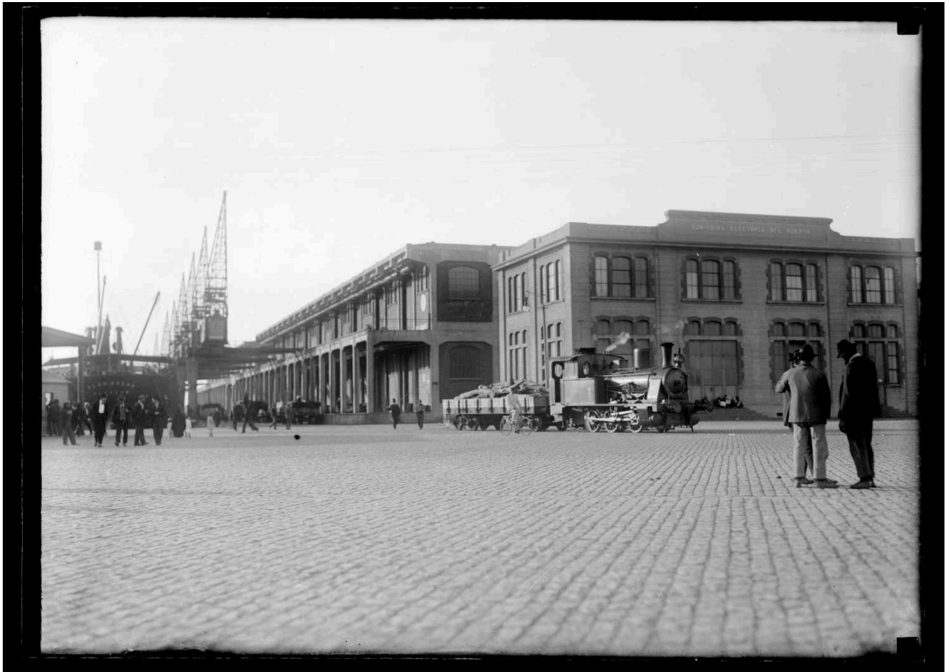
El Puerto de Montevideo: almacenes y grúas. Año 1911. (Fuente: Centro de Fotografía. Dominio público).
