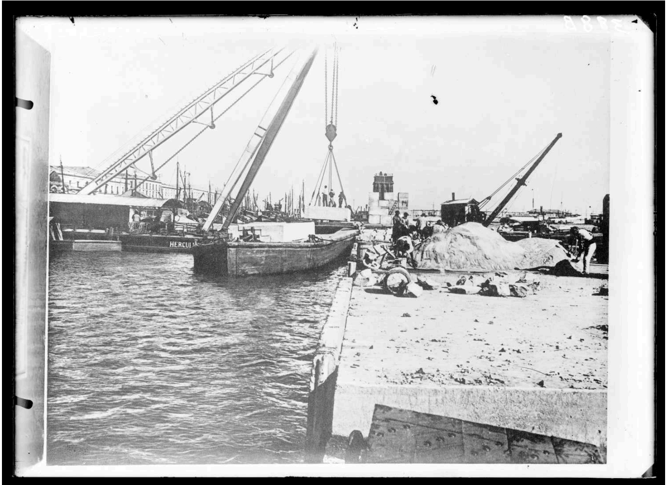
El Puerto de Montevideo en construcción. Año 1901. (Fuente: Centro de Fotografía. Dominio público).
