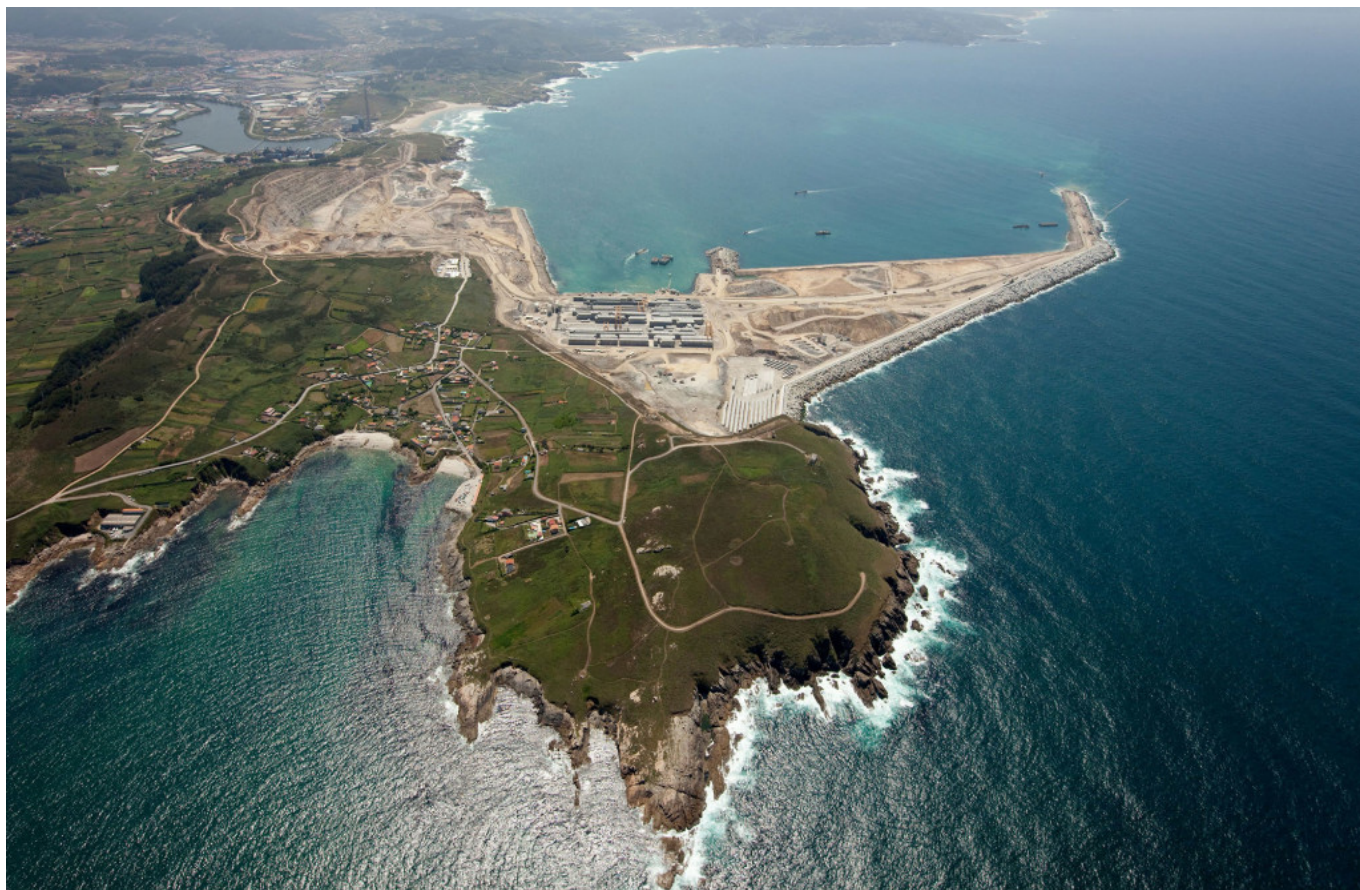
Punta Langosteira, la nuova struttura portuale in corso di realizzazione.
