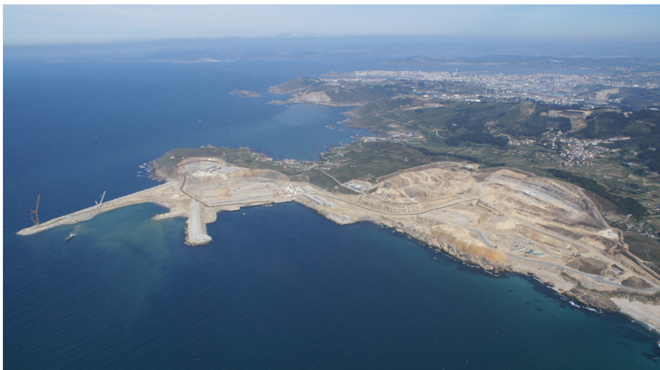
La nuova area portuale di Punta Langosteira; sullo sfondo la città e il porto storico.
