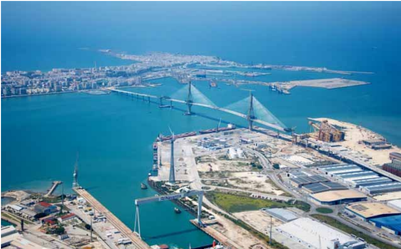
Vista aérea actual, con el nuevo puente y últimos rellenos.
