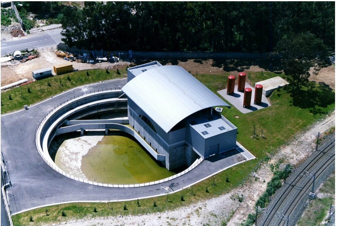
Estación general de bombeo. (Foto Universidad de Cantabria)
