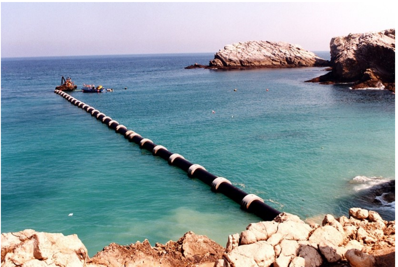
Construcción del emisario submarino. (Foto Universidad de Cantabria)
