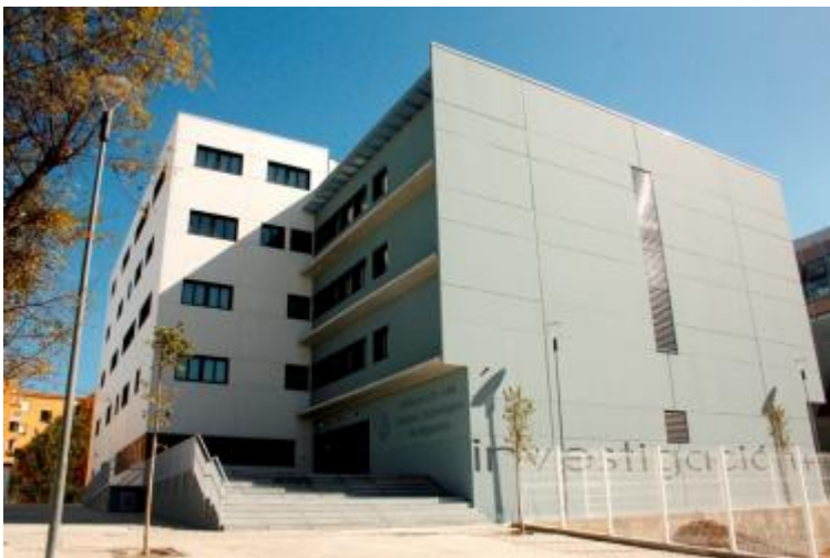
Edificio I+D+i del Campus Tecnológico de Algeciras, sede de la Fundación Campus Tecnológico de Algeciras.
