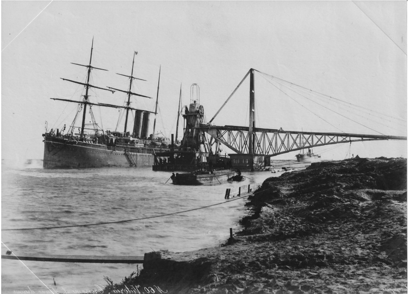
Vertido del producto del dragado.
