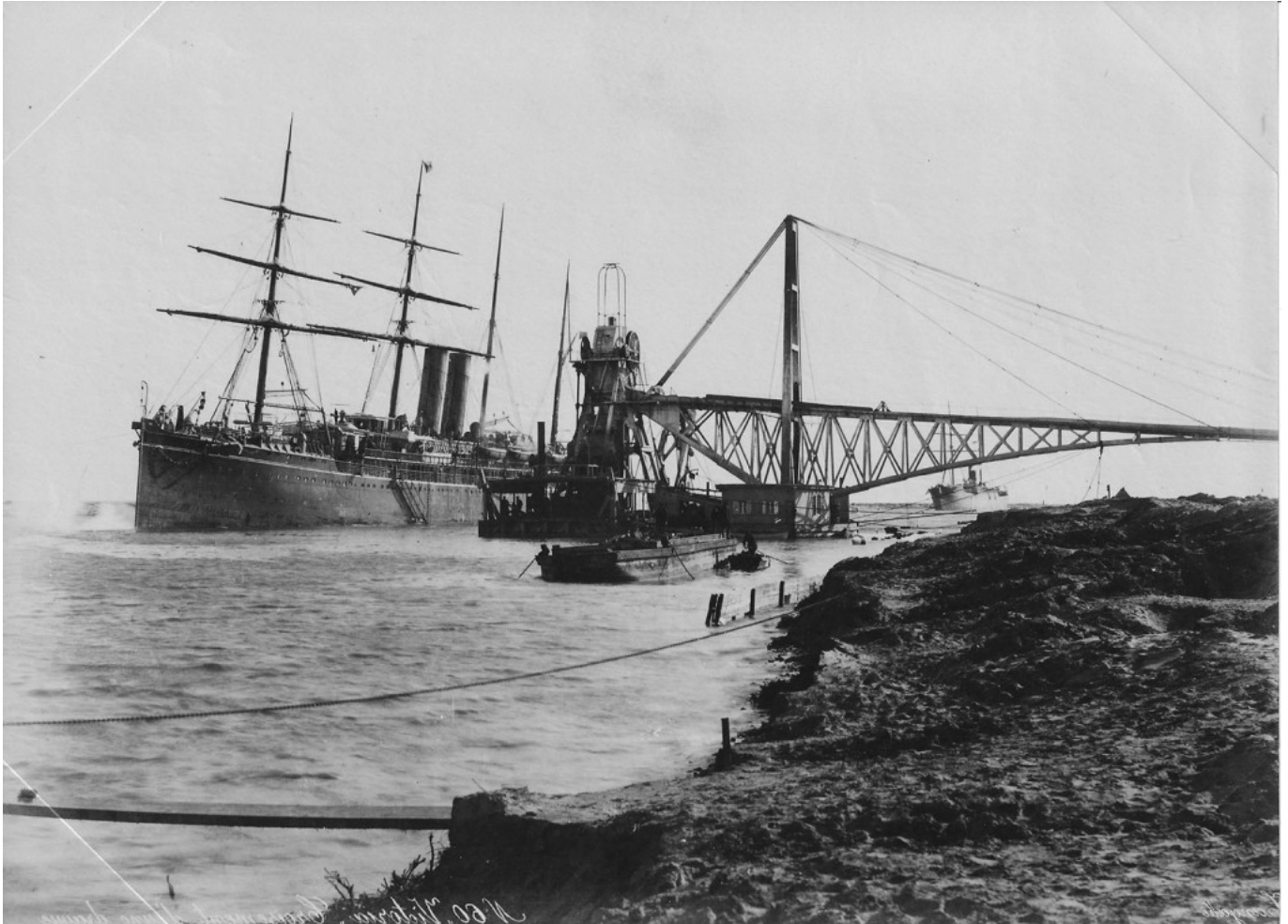
Vertido del producto del dragado.
