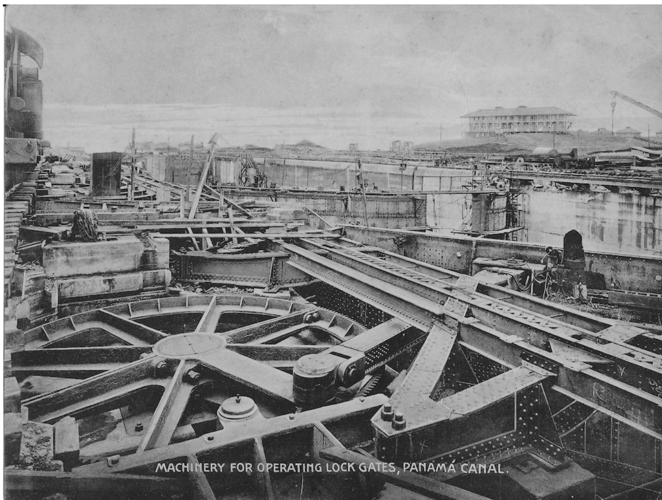
Maquinaria de las compuertas.
