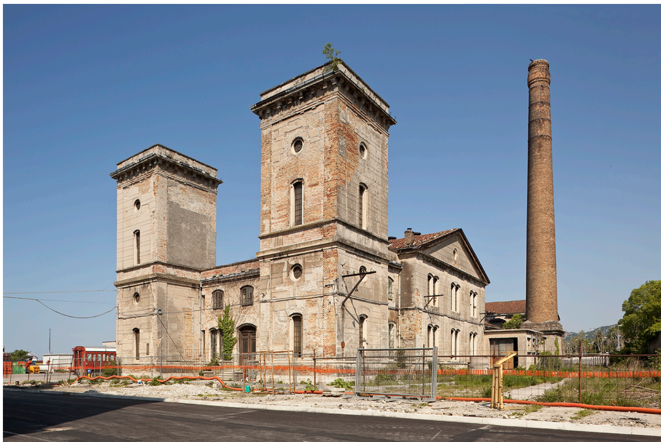
Porto Vecchio di Trieste: la Centrale idrodinamica prima del restauro. (Foto: Neva Gasparo)
