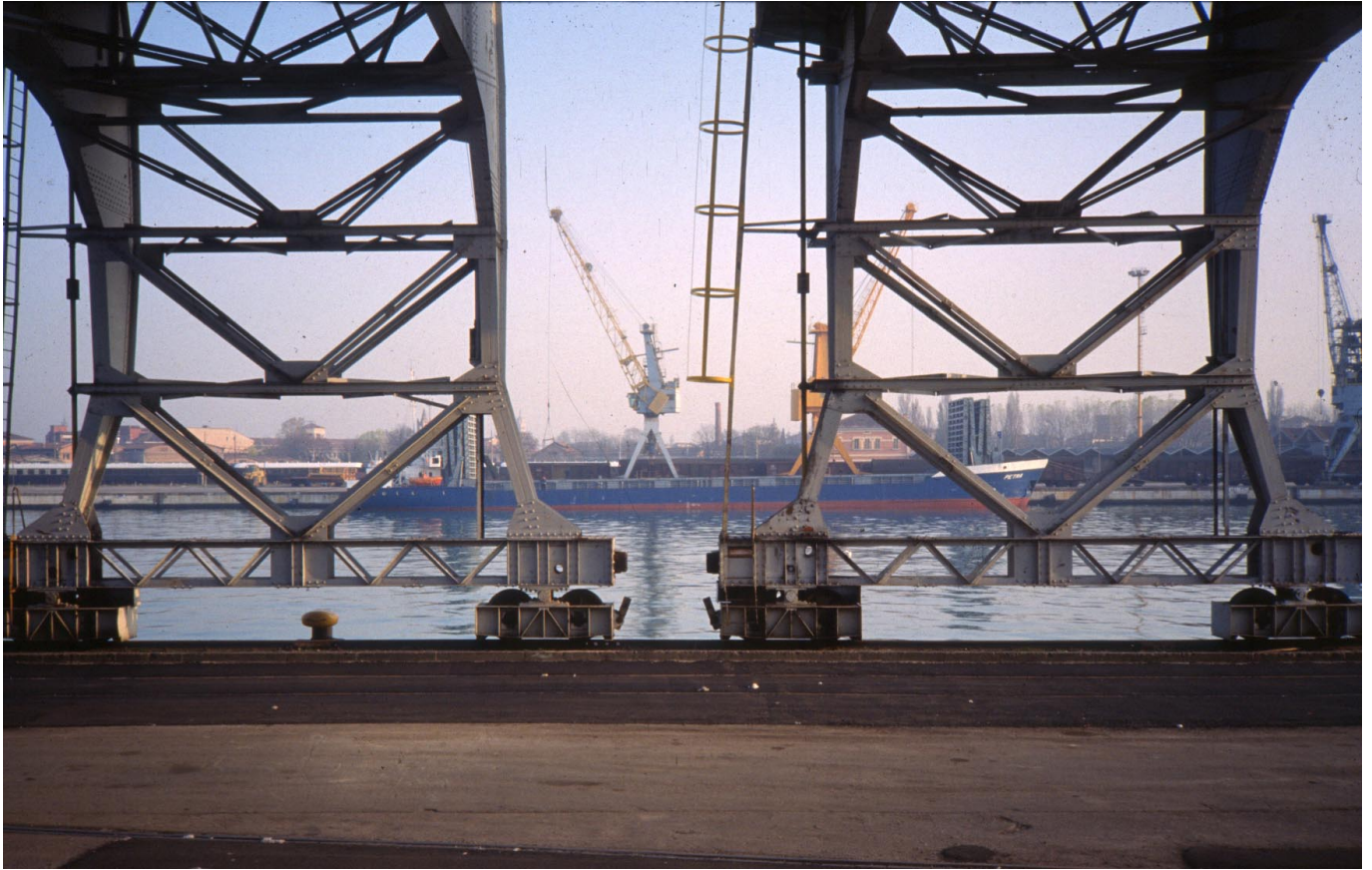
Banchine gru alla Stazione Marittima negli anni '80, prima della dismissione. (© Franco Mancuso)
