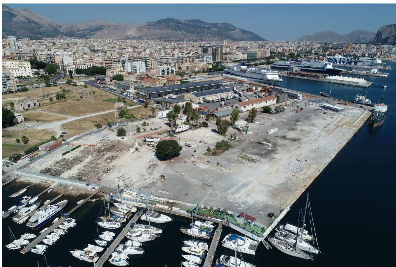
Il Molo Trapezoidale dopo le demolizioni. (Fonte: Autorità di Sistema Portuale del Mare di Sicilia Occidentale).
