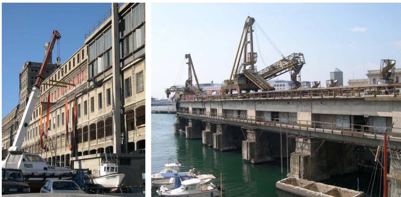
Silos granari di Santa Limbania "Hennebique", veduta dell'esterno e del molo demolito 2010. (© S. De Maestri)
