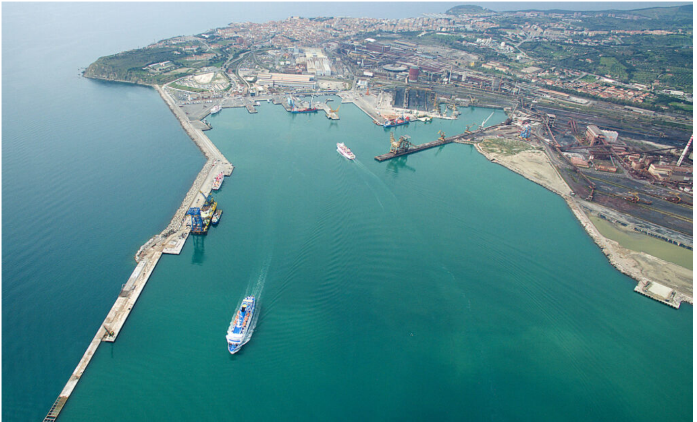
Veduta panoramica del Porto di Livorno. (© Autorità di Sistema Portuale del Mar Tirreno Settentrionale).
