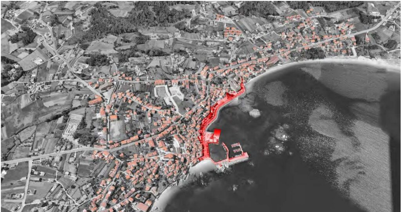
Vista aérea de la zona de actuación de la obra de mejora de la movilidad y accesibilidad en el puerto de Palmeira. (Fuente: Portos de Galicia, 2022).
