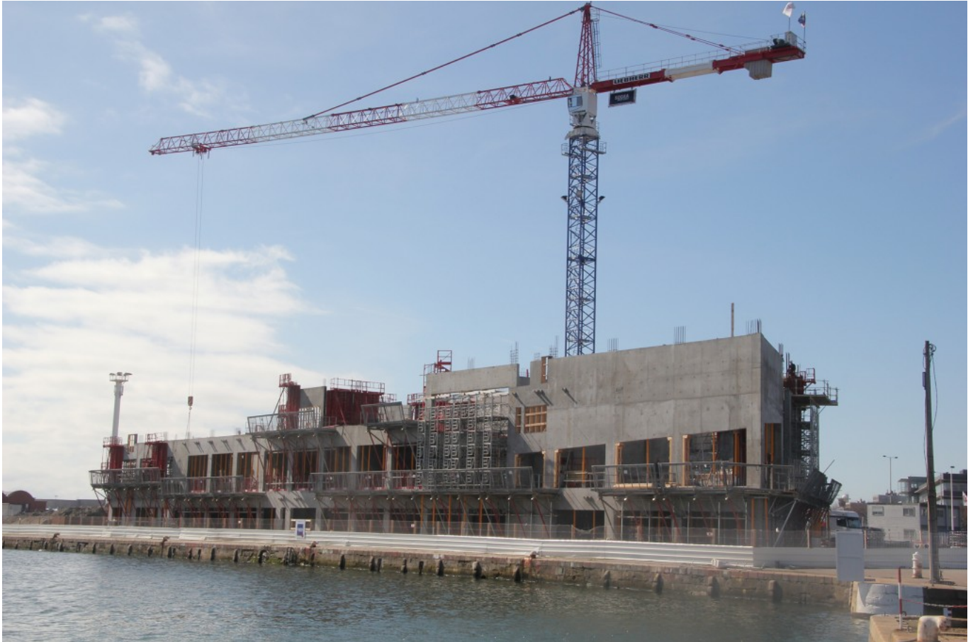
Construction of Ecole Nationale Supérieure Maritime (ENSM), Le Havre. (© AIVP)
