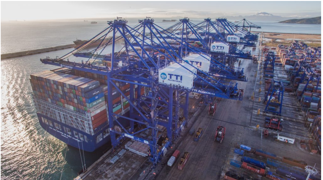
Vista aérea de la terminal semi-automática TTIA en el Puerto Bahía de Algeciras. (© Apolo. Propulsora de Marcas, TTIA y Autoridad Portuaria de la Bahía de Algeciras - APBA, 2018).
