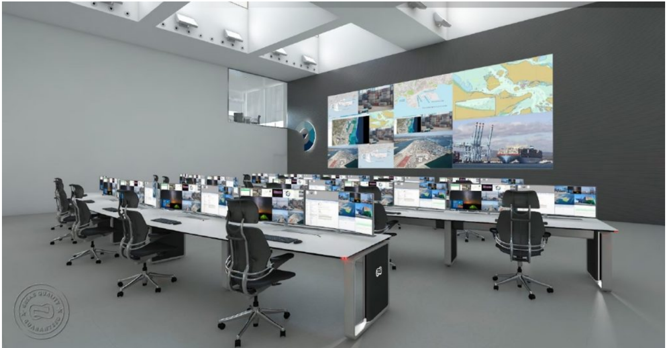
Centro de Coordinación de Procesos de la APBA junto con la Plataforma de Orquestación de Operaciones. (© Autoridad Portuaria de la Bahía de Algeciras - APBA, 2021).
