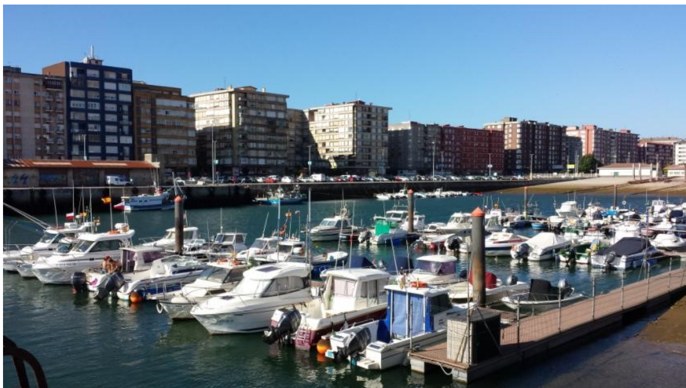
Muelle norte de la Dársena de Maliaño y Varadero, zona sobre la discurrirá el paseo marítimo en construcción. (Foto: Román R. Luna)
