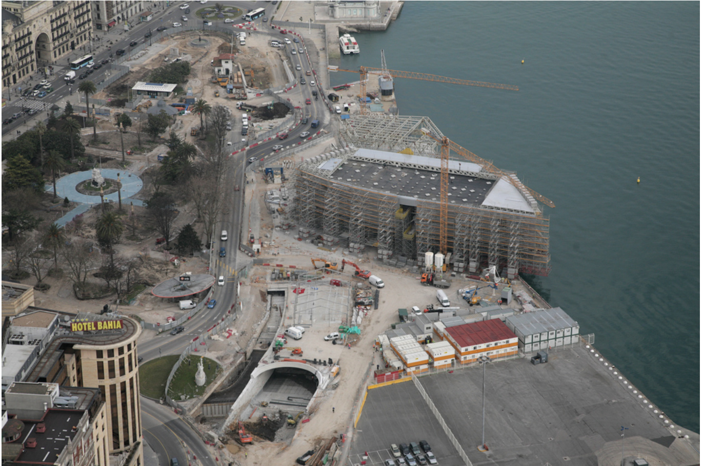
Estado de las obras del Centro Botín en marzo de 2014. (Colección APS. Foto: Foto Asturias S.L.)
