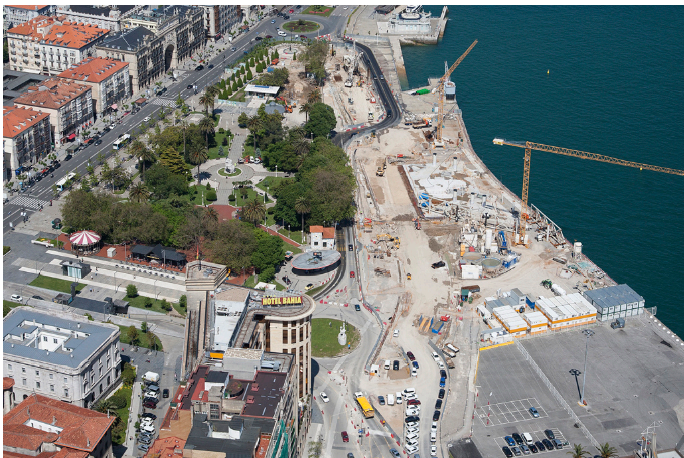
Estado de las obras del Centro Botín en 2013. (Colección APS. Foto: Foto Asturias S.L.)
