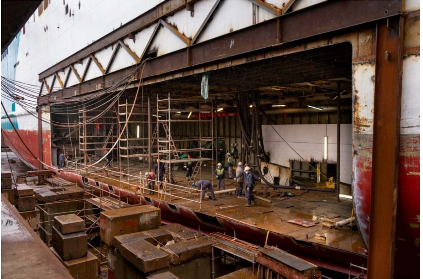
Navio em reparação. (© Fonte: West Sea, 2022).
