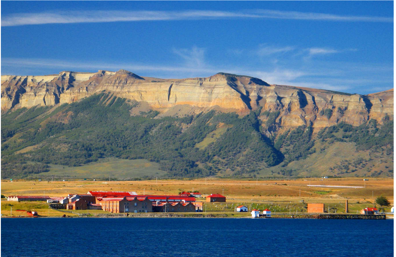
Volúmenes patrimoniales antes de la intervención. (Autor: Pedro Kovacic)
