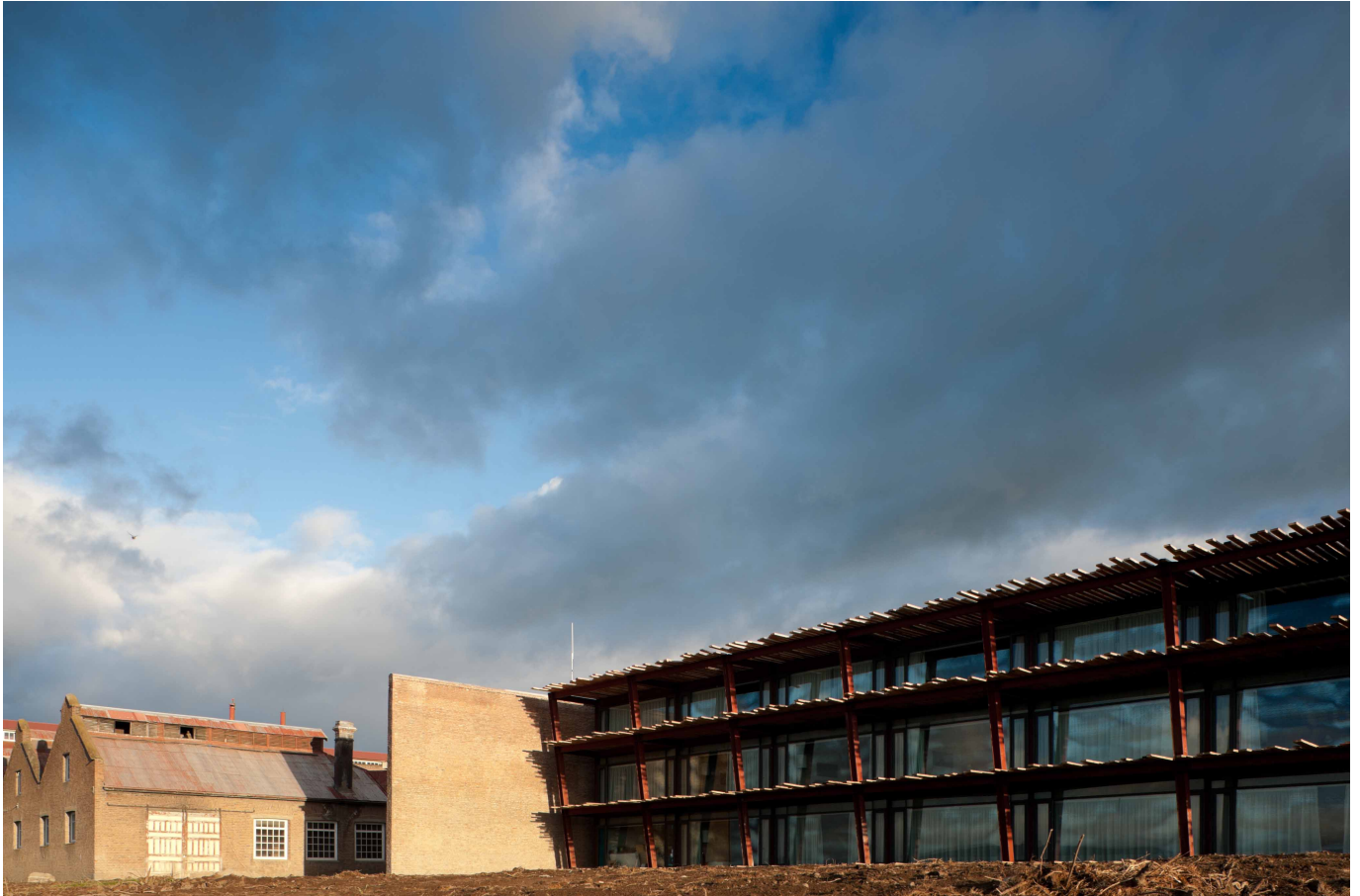
Pabellón de habitaciones entre muros del ex frigorífico. (Autor: Pedro Kovacic)
