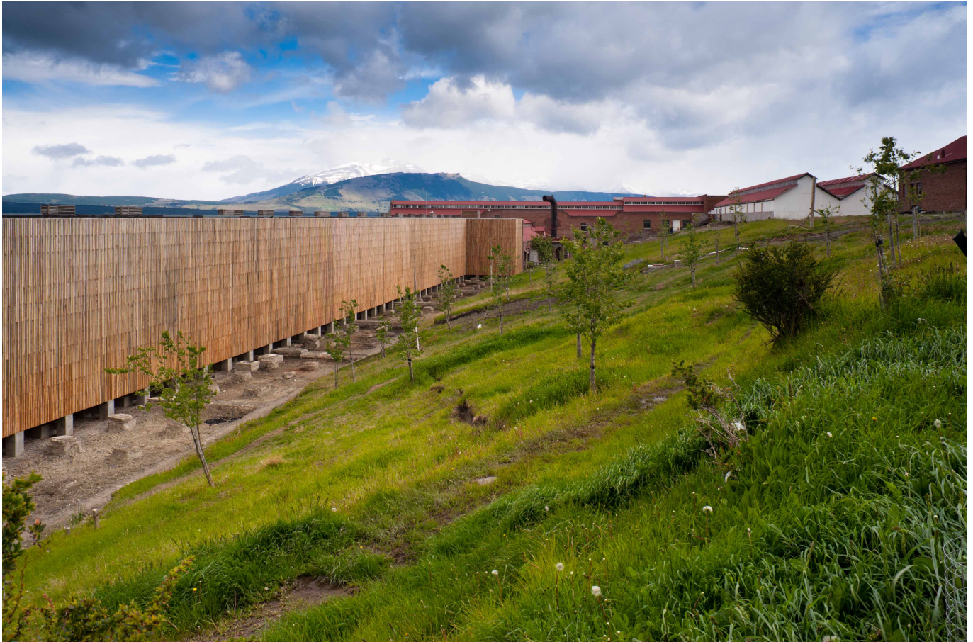
Fachada entramado de madera en volumen de habitaciones. (Autor: Pedro Kovacic)
