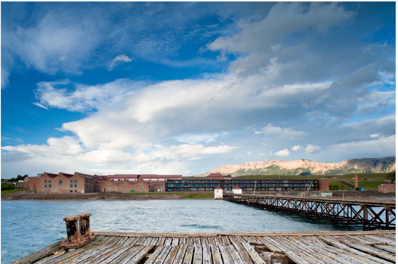
Vista general desde el muelle de carga. (Autor: Pedro Kovacic)
