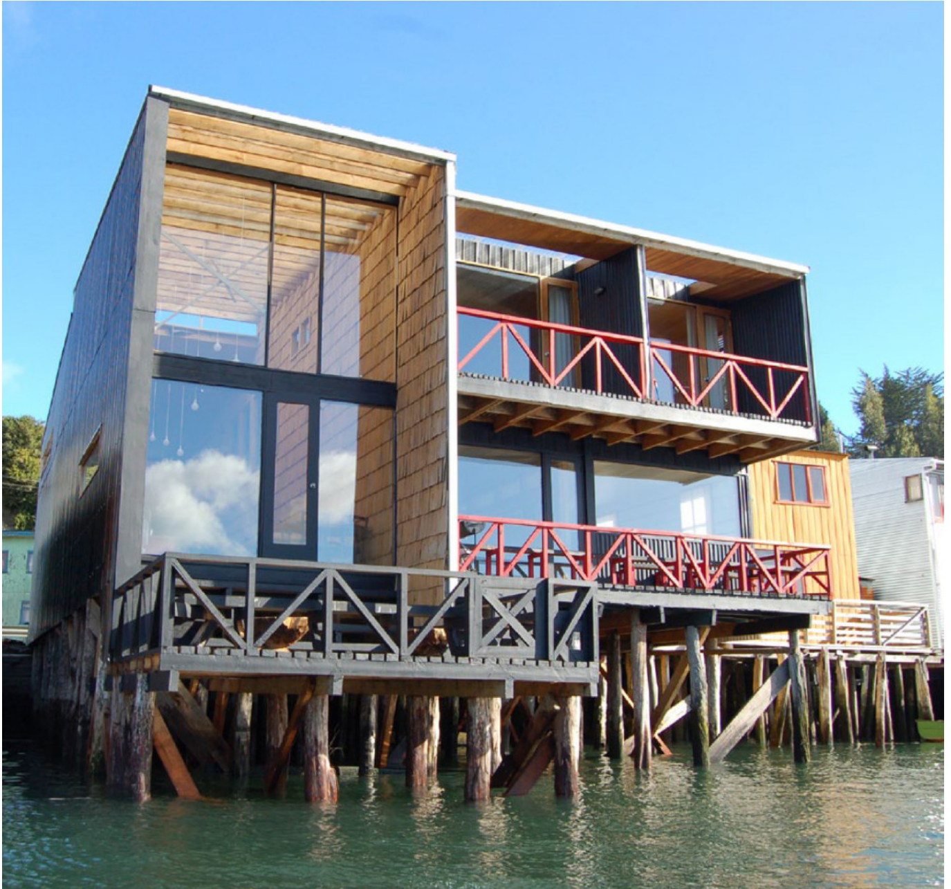
Palafito hostel - barrio Pedro Montt en Castro. (Fotografía Jonás Retamal Tobar)
