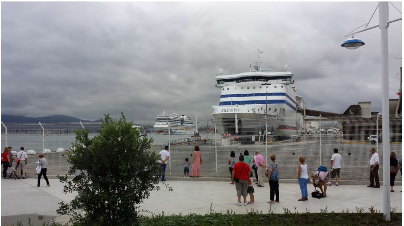
Terminal de pasajeros del Puerto de Santander. (Fuente: Autoridad Portuaria de Santander)
