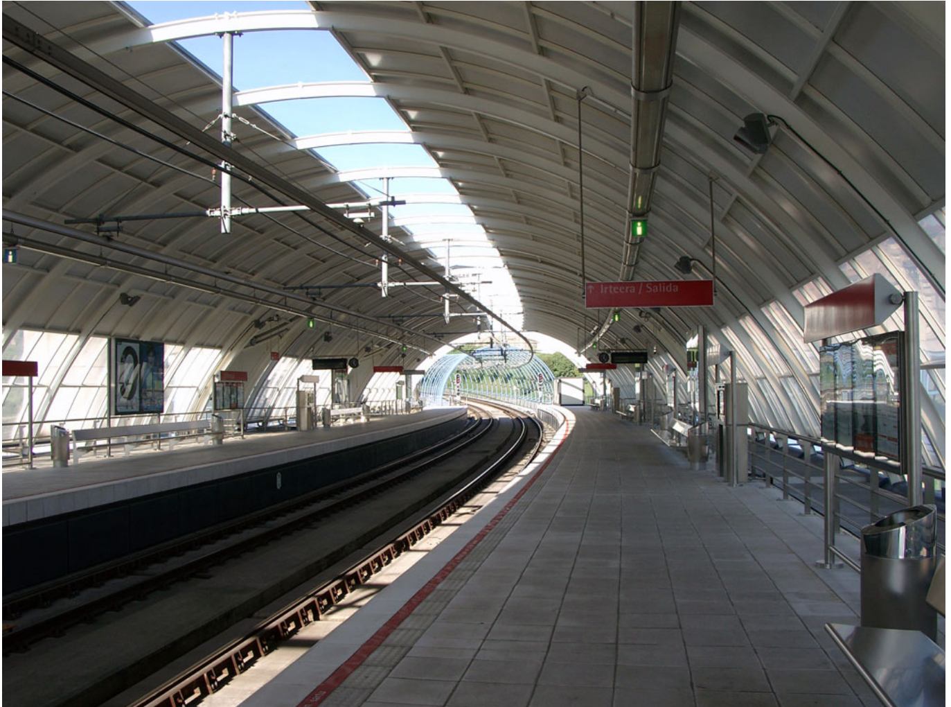
La estación Urbinaga de metro en Bilbao.
