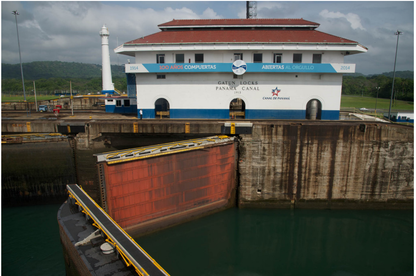
Edificio de control de las esclusas de Gatún.
