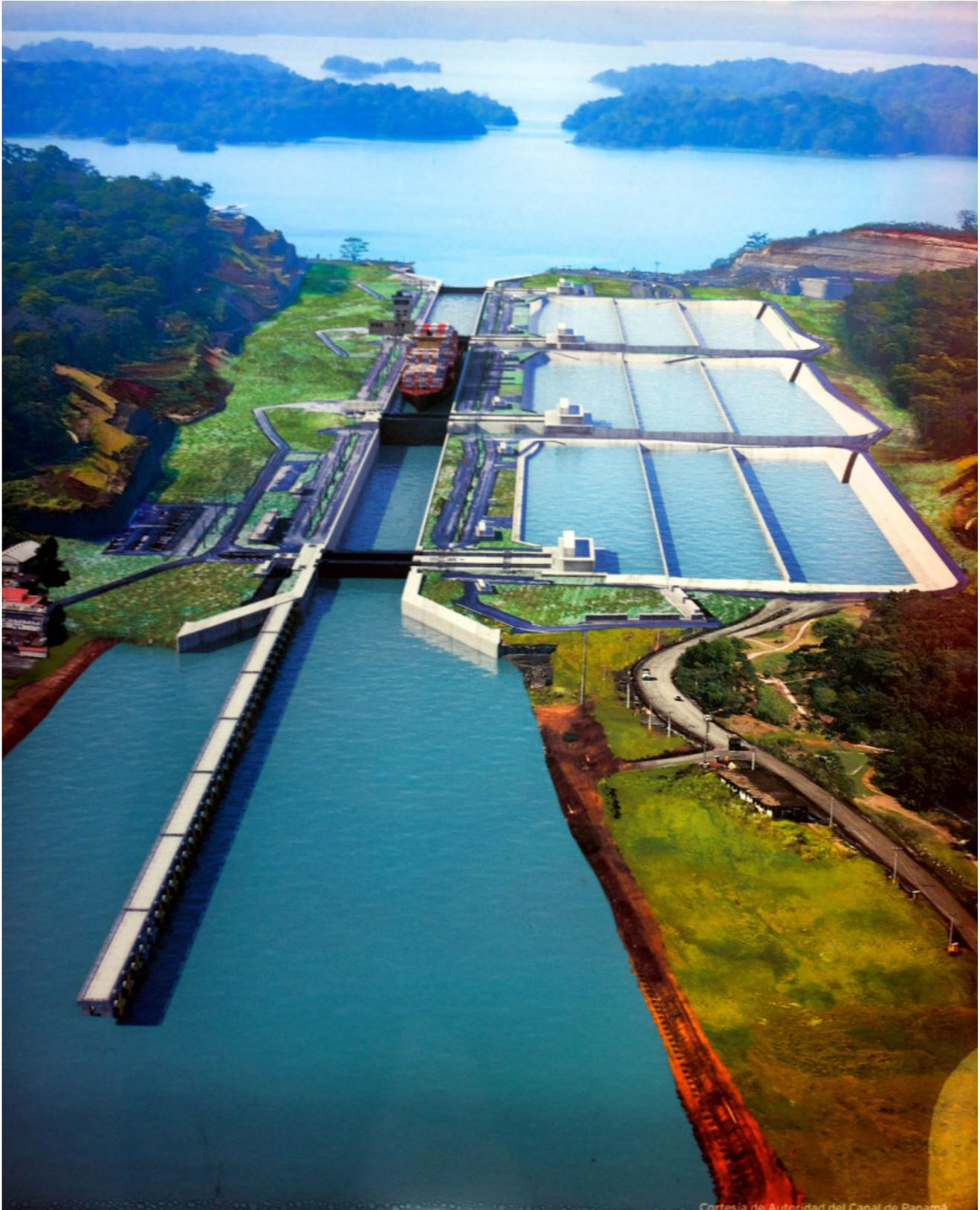
*Imagen virtual del tercer juego de esclusas con el muelle de aproximación, las tres cámaras y las piletas de reutilización.*
