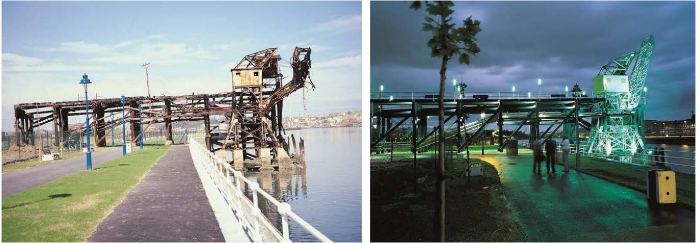
Cargadero de mineral en Barakaldo (antes y después).
