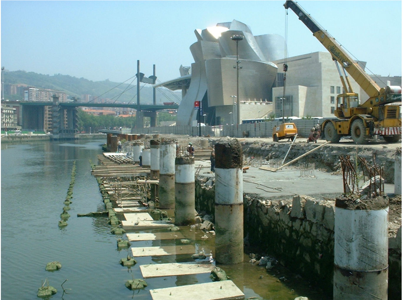
Obra de recorte del muelle en Abandoibarra (imagen de la antigua cimentación y de la nueva estructura)
