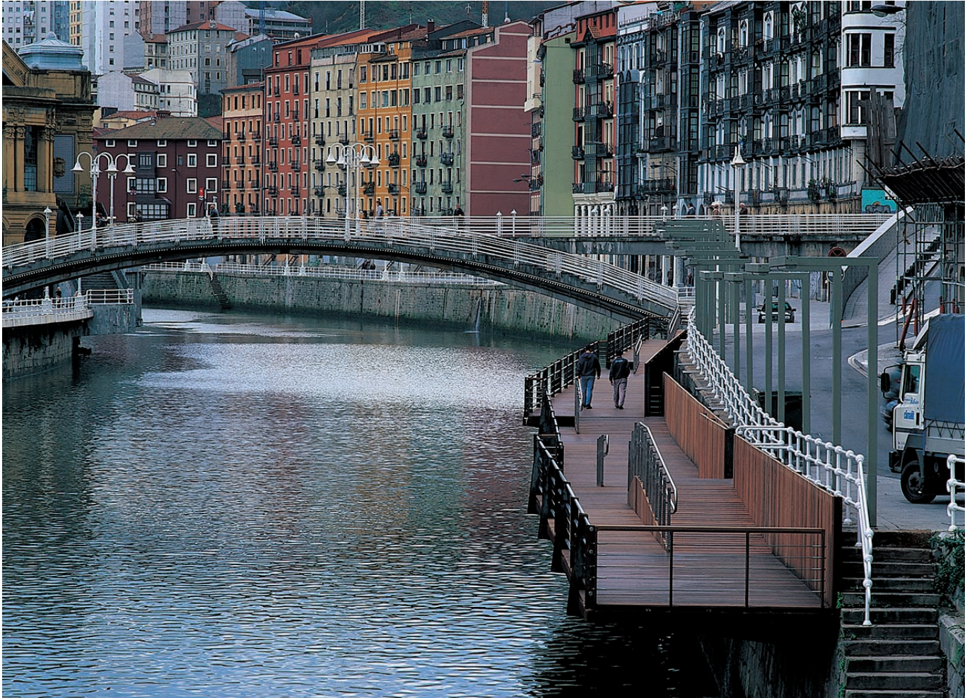
Muelle en voladizo sobre la Ría en Bilbao la Vieja.
