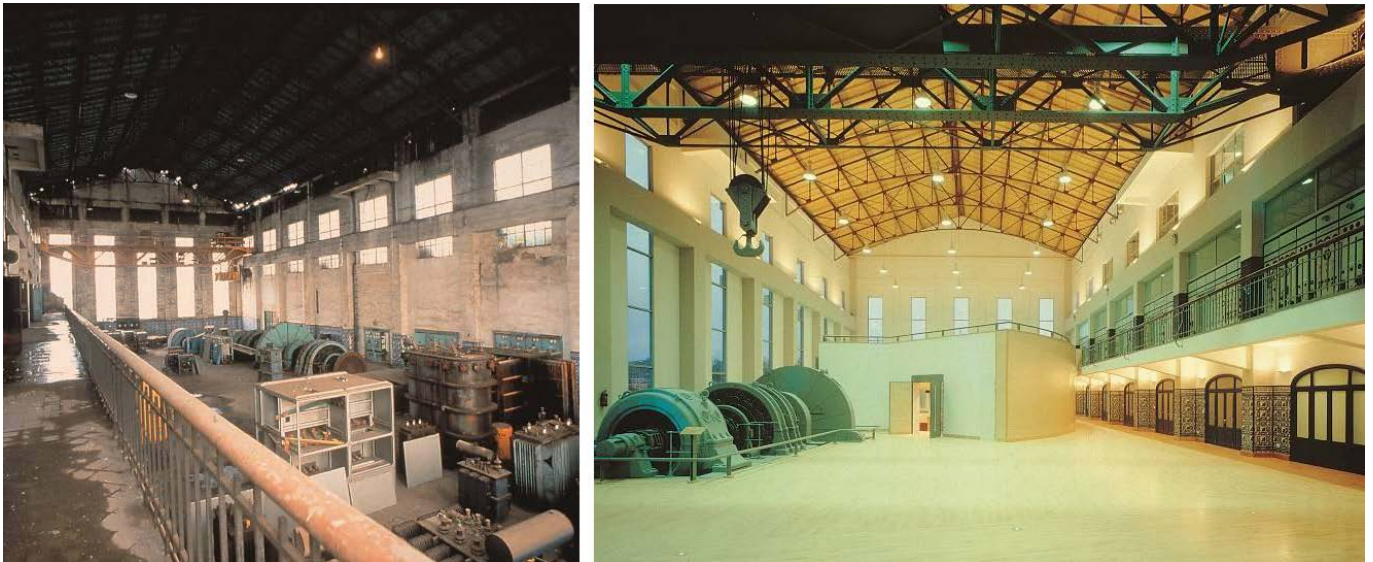
Interior del edificio Ilgner antes y después de su rehabilitación.
