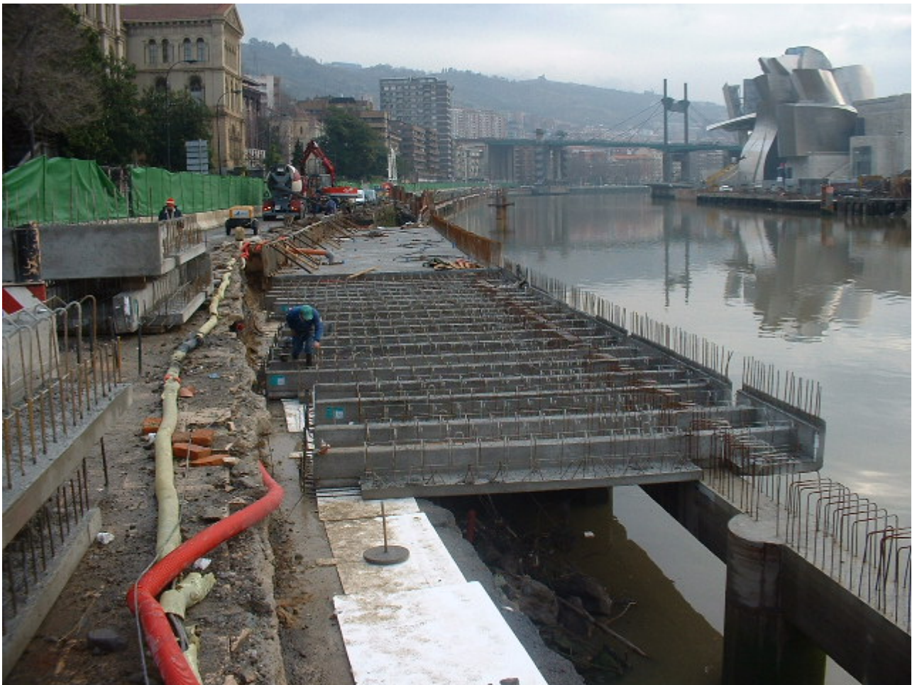
Obra de ampliación de la Avenida de las Universidades.
