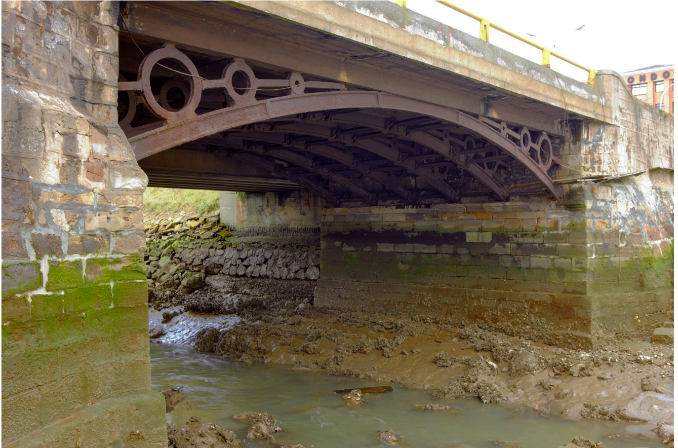
Puente de Udondo, formado por un arco del Puente de Isabel II) de Bilbao. (Fotografía del autor, 2009).
