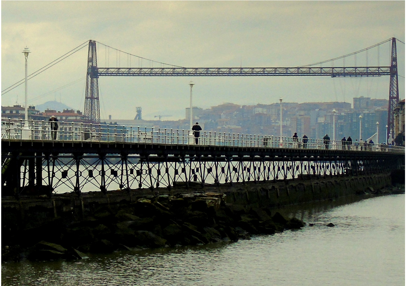
Muelle de Hierro de Portugalete y Puente transbordador Vizcaya. (©Iñaki Zarragoitia, 2017).
