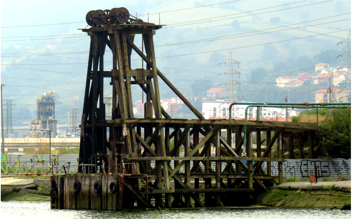
Cargadero de mineral de 1877 de la Orconera Iron Ore en Lutzana-Barakaldo. (© Iñaki Zarragoitia, 2015).
