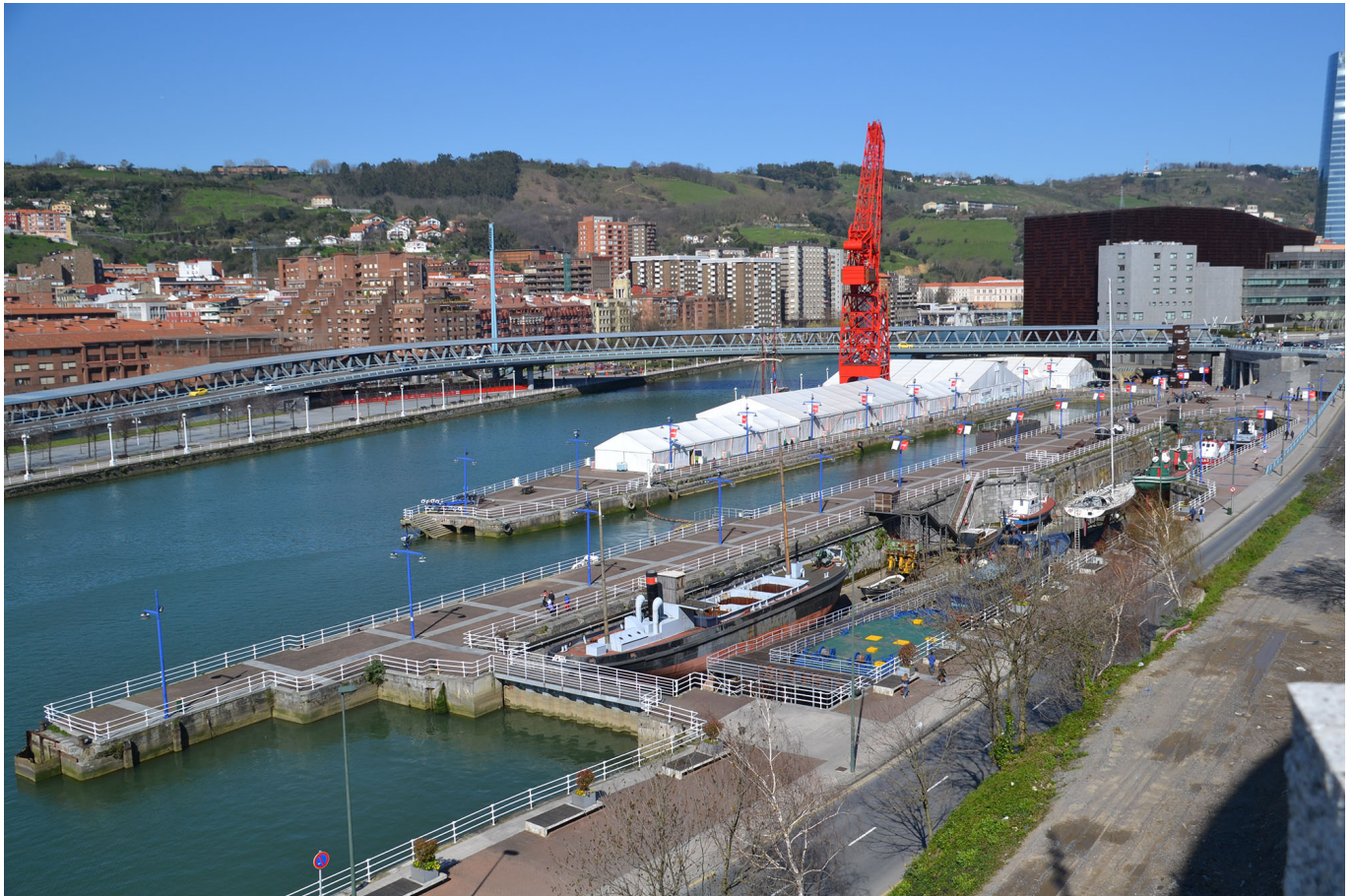
Diques secos del astillero Euskalduna y grúa Carola. A la derecha, fuera de la imagen, se conserva casa de bombeo original con su maquinaria. (Fotografía del autor, 2015).
