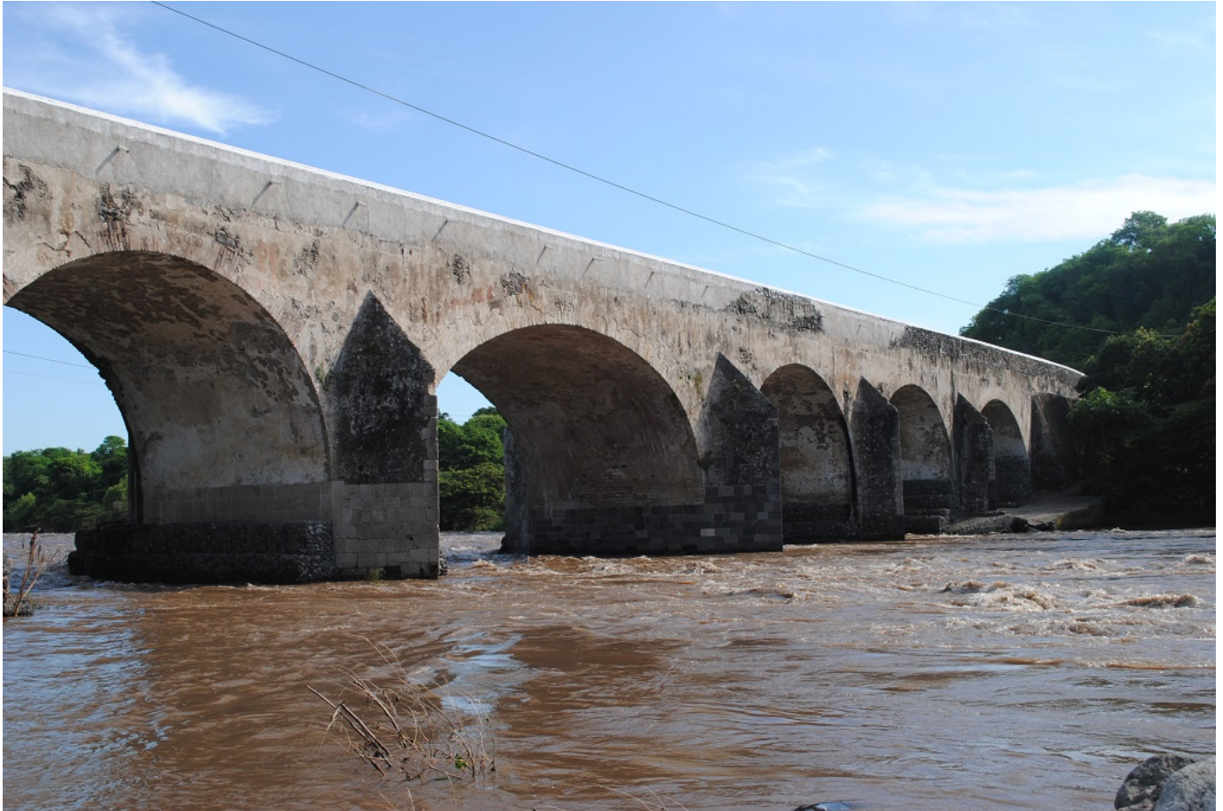
Vista del puente del Rey o puente Nacional. (Foto: Aníbal del Ángel, 2013)
