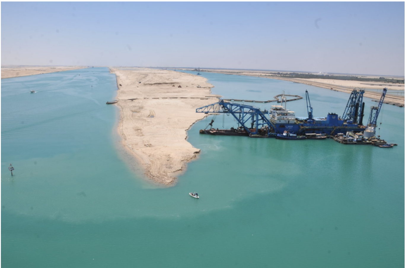
Las obras para la ampliación del Canal de Suez.
