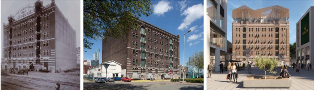
(a) Historic image of Santos warehouse. (Source: https://www.rotterdam.nl/wonen-leven/rijnhaven/180816-doc-cultuur-historische-verkenning.pdf ; p.64)
