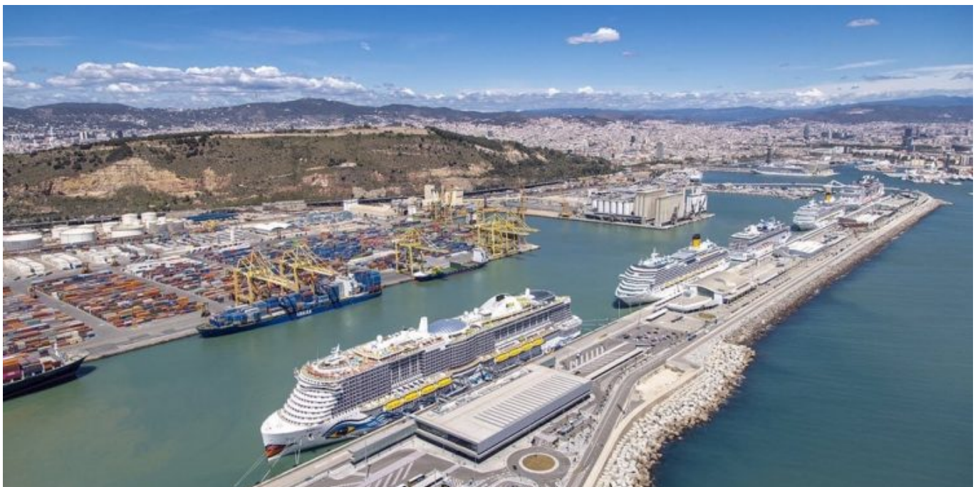
Terminales de cruceros en el muelle Adosado del puerto de Barcelona. (Fuente: El Estrecho Digital).
