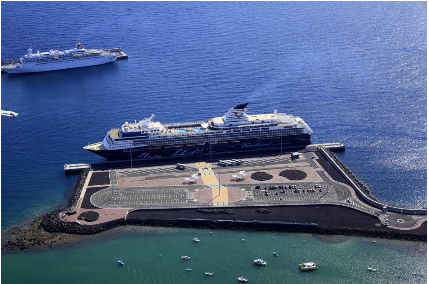
Zona de maniobra y área de transporte terrestre, en una terminal de cruceros de tránsito, en el muelle de Naos, puerto de Arrecife. (Fuente: Autoridad Portuaria de Las Palmas).
