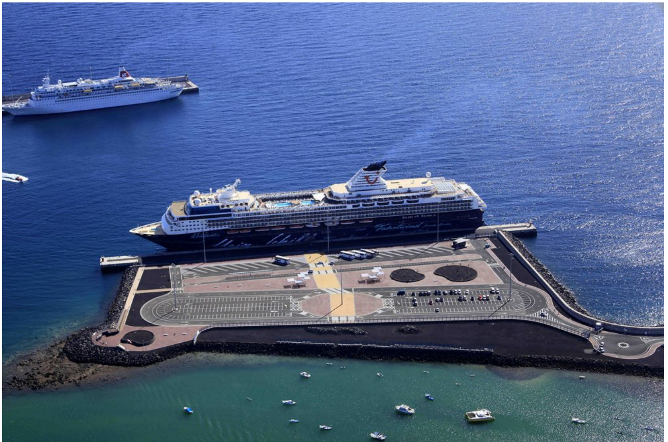
Zona de maniobra y área de transporte terrestre, en una terminal de cruceros de
