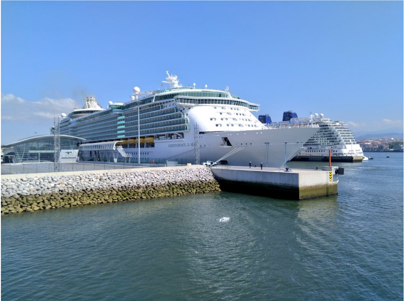
Zona de maniobra de la terminal de cruceros del puerto de Bilbao. (Fuente: Turismovasco).
