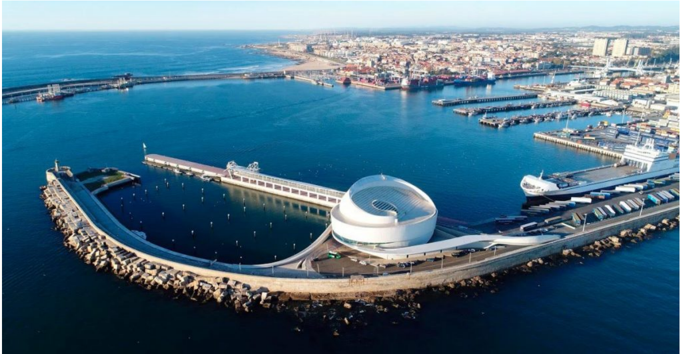
Terminal de cruceros del puerto de Leixoes.
