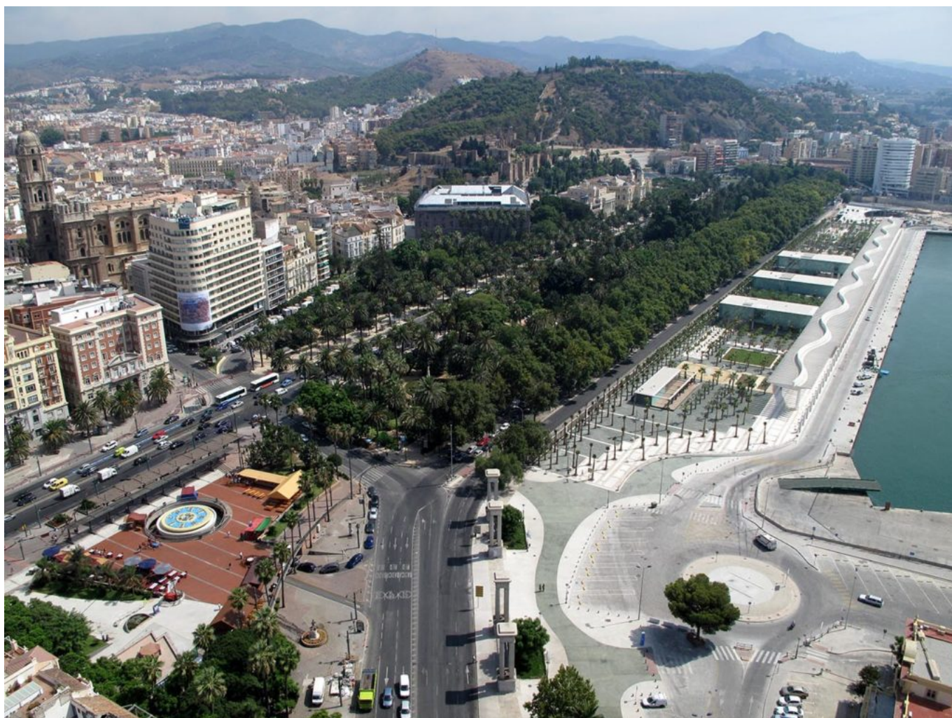
Terminal para cruceros de pequeño porte, integrada en “El Palmeral de las Sorpresas”, en el muelle 2 del puerto de Málaga.
