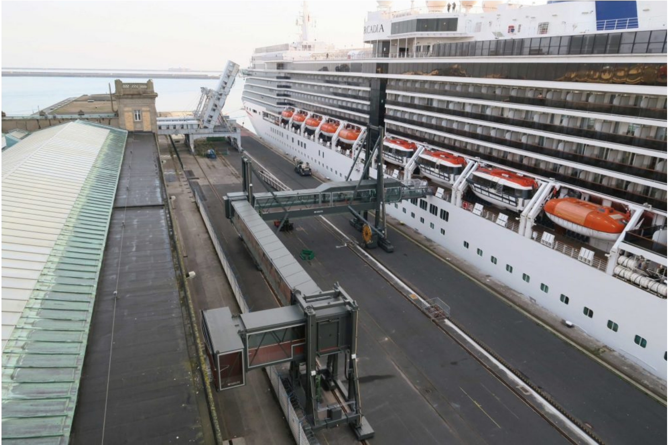
Pasarela móvil en el puerto de Cherbourg. (Fuente: Adelte).
