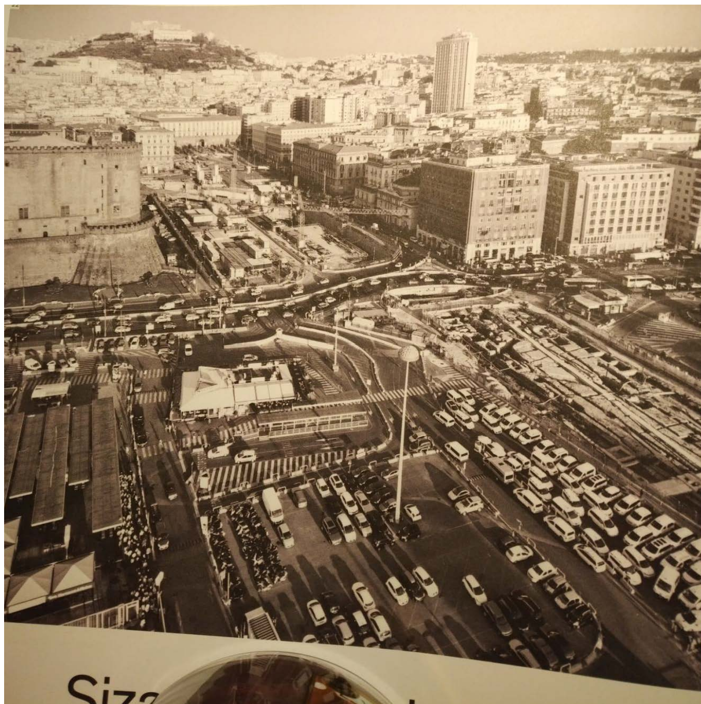
Veduta aerea della Piazza Municipio e dell'area portuale in prossimità del Molo Beverello. Si nota il cantiere per la realizzazione della nuova stazione della Metropolitana. (Fonte: Casabella, 869, gennaio 2017)
