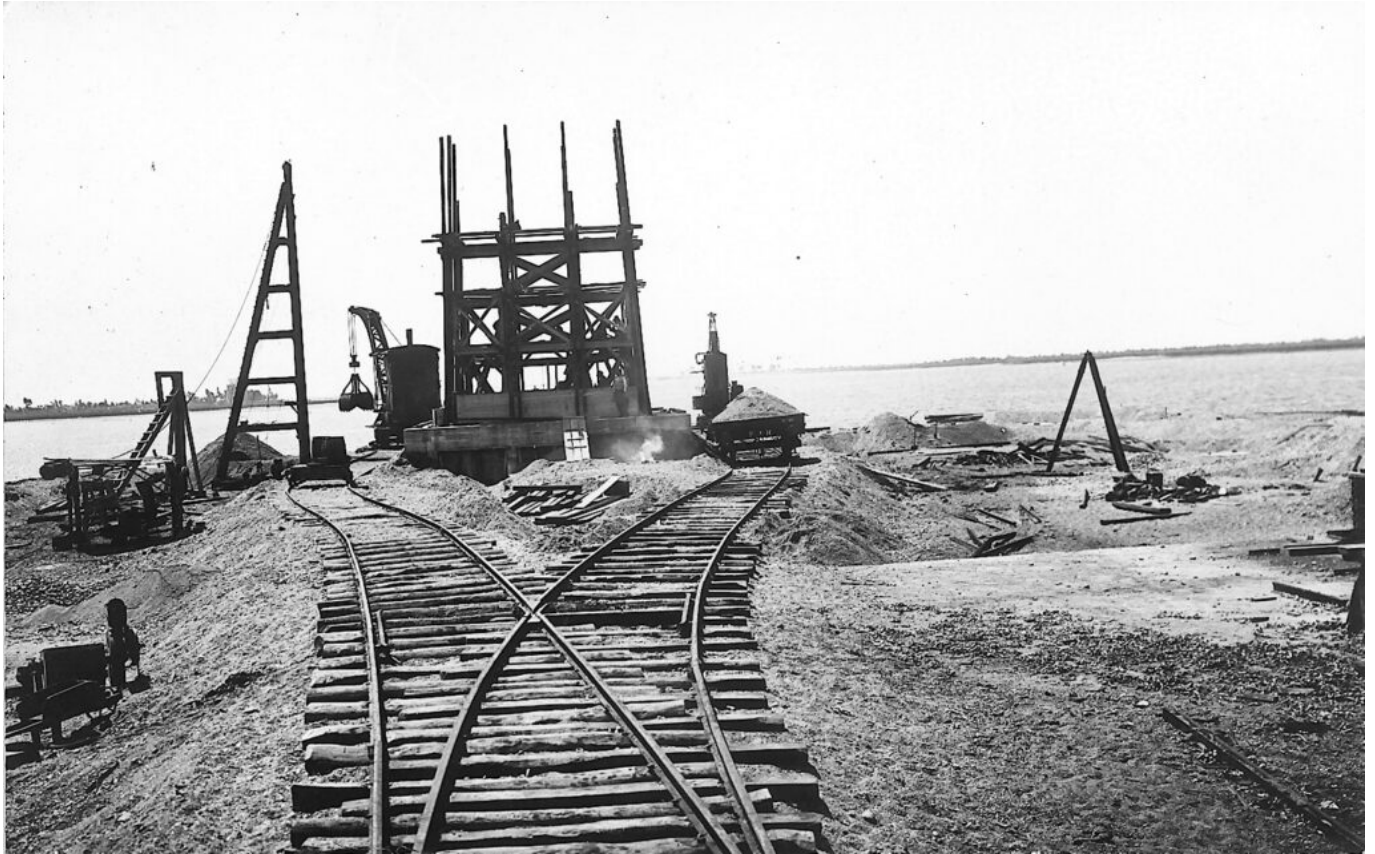
Inicio de las obras del Monumento a Colón, 1928. (Fuente: Archivo Autoridad Portuaria de Huelva).
