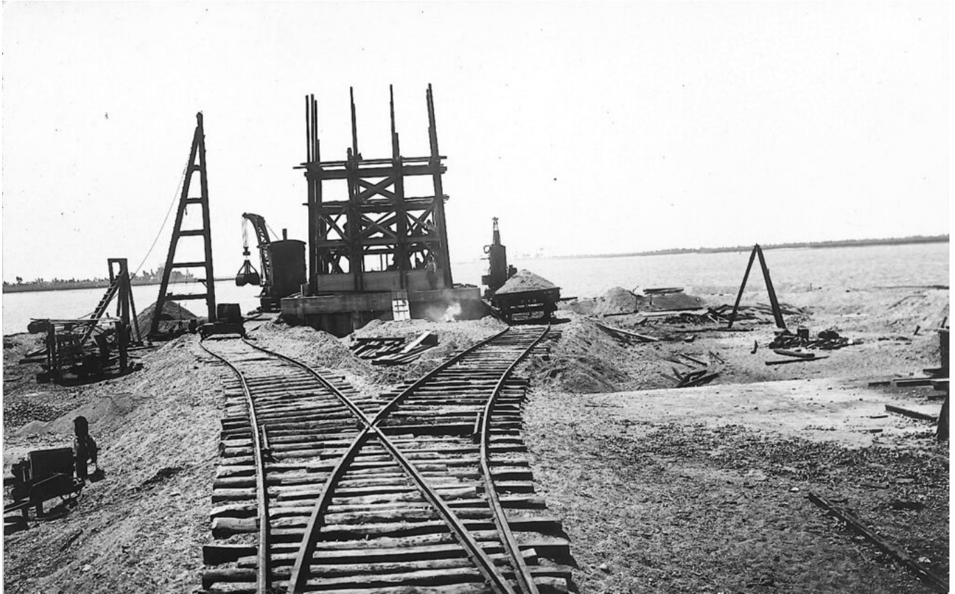
Inicio de las obras del Monumento a Colón, 1928. (Fuente: Archivo Autoridad Portuaria de Huelva).
