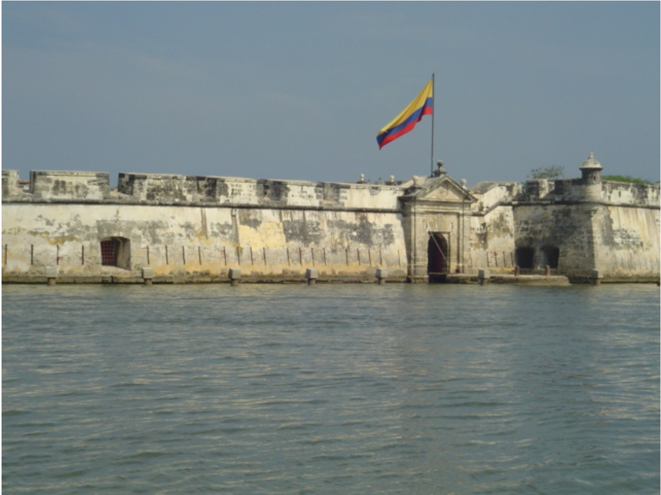
Fuerte de San Fernando de Bocachica. (Foto: Maruja Redondo Gómez)
