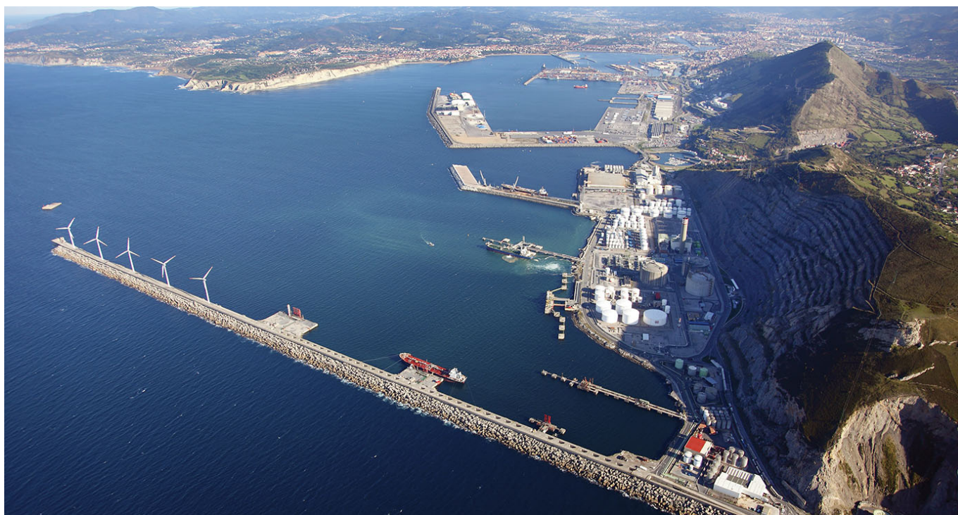
Vista general del puerto de Bilbao. El Dique de Punta Lucero en primer término.
